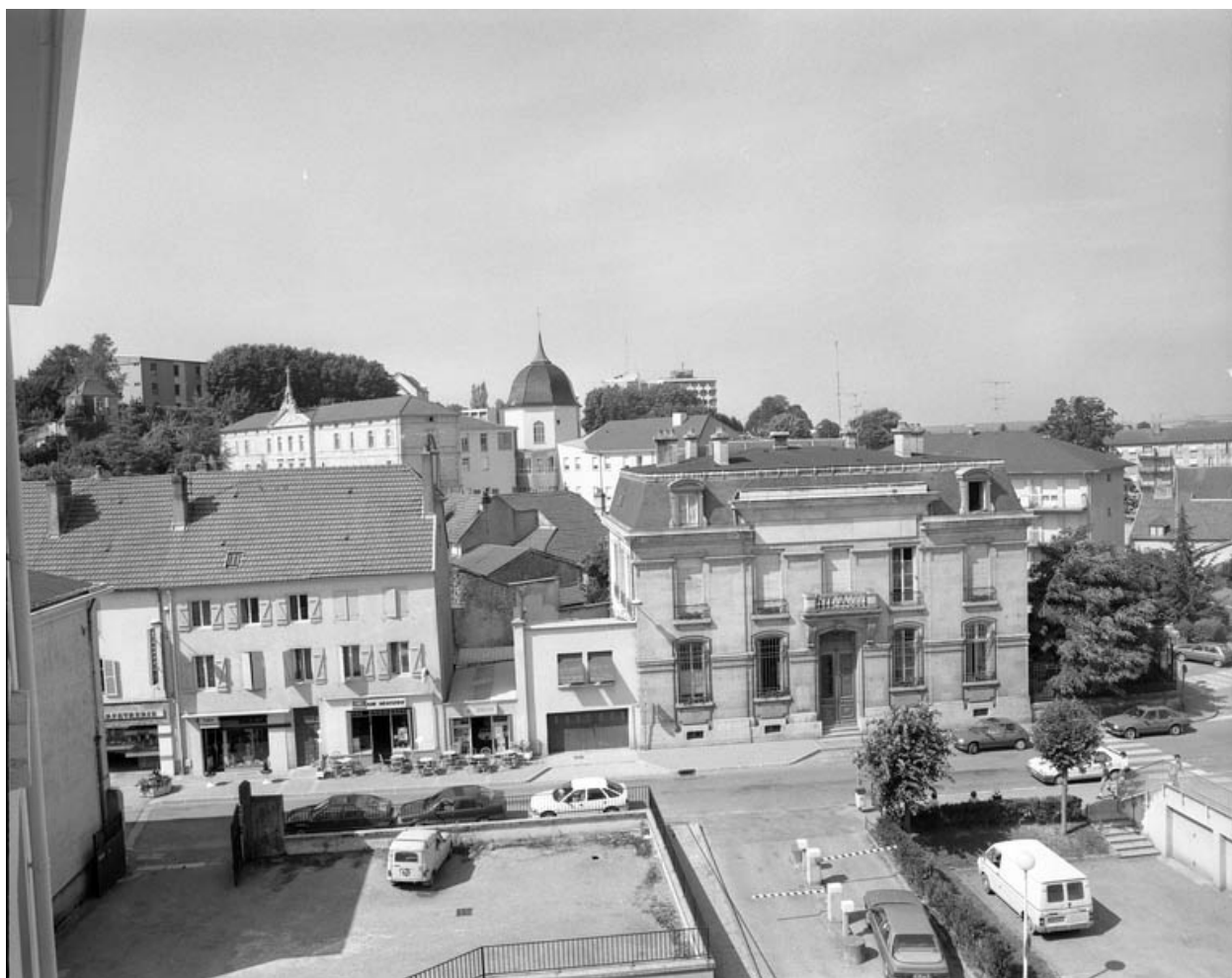
Vue d'ensemble éloignée.
