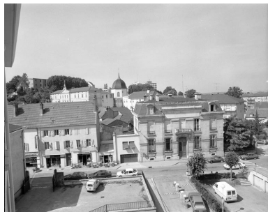
Vue d'ensemble éloignée. Phot. Yves Sancey IVR43_19917000262X
