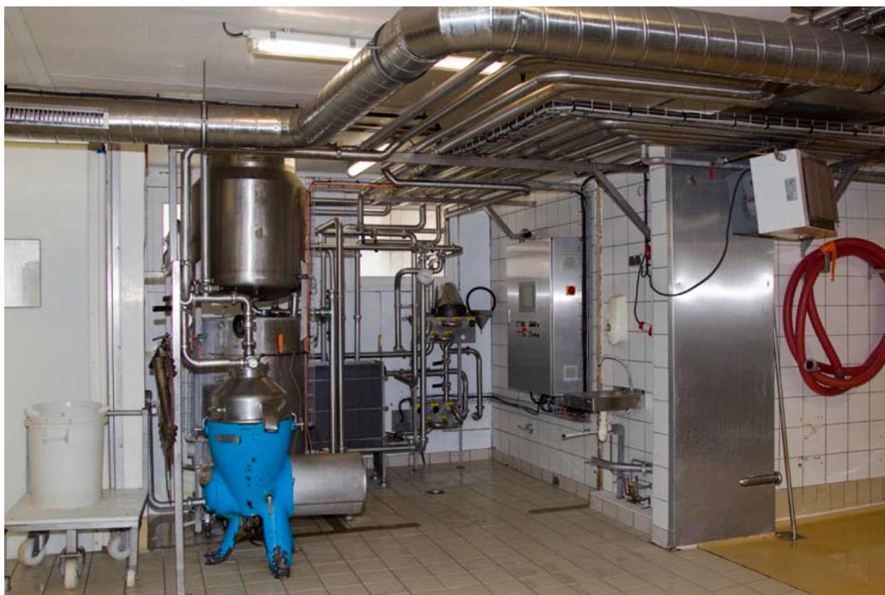
Écrémeuse et installation de dépotage du lait et refroidissement du sérum.
