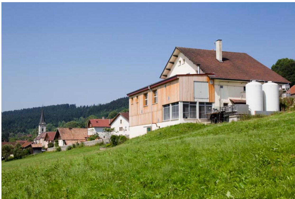
Vue d'ensemble depuis la prairie, au sud-est.
