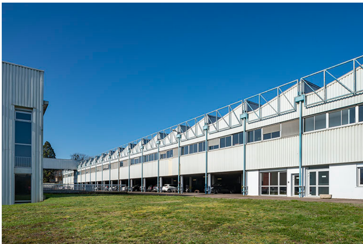
Façade est de l'atelier principal de fabrication.
