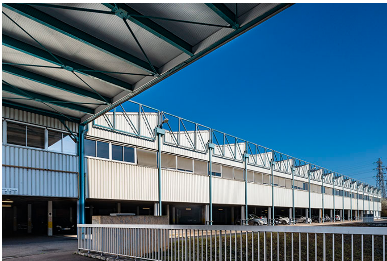
Atelier de fabrication. Sheds de la façade est.
