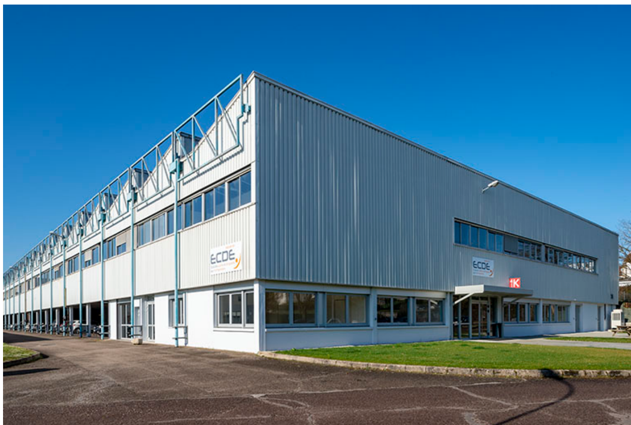
Atelier de fabrication vu depuis le nord-est.
