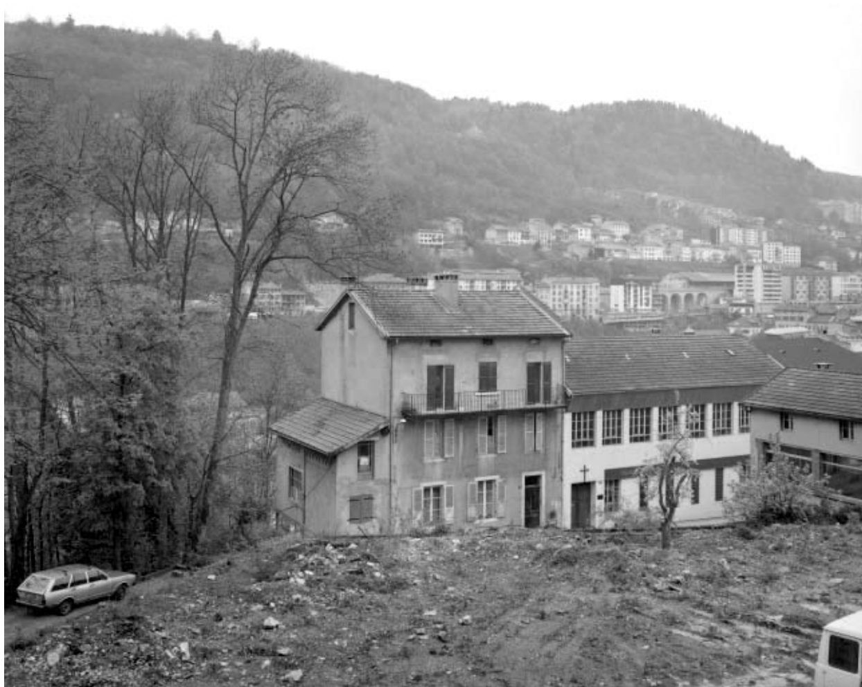
Vue d'ensemble de la façade antérieure.
