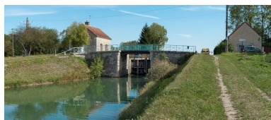
Le pont de l'aval.
