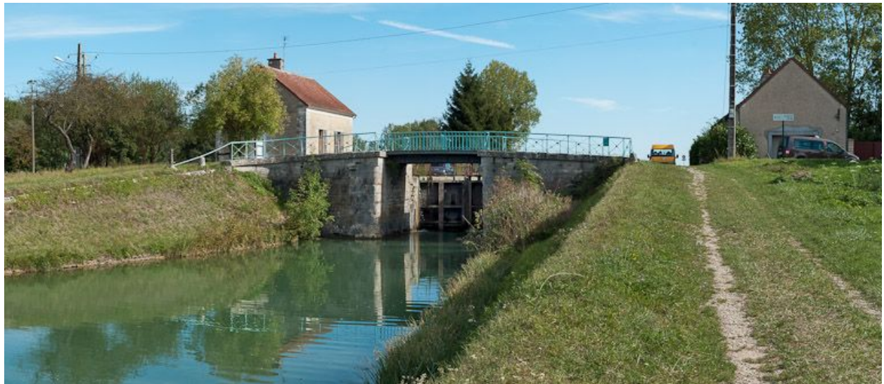
Le pont de l'aval.
