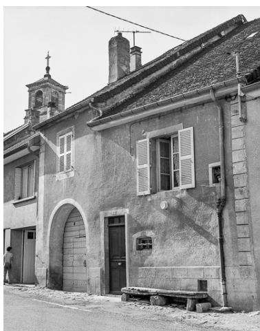
Ferme située à Perrigny. Phot. Dominique Dominguez IVR43_19803900178X
