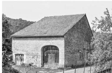
Ferme située à Publy. Phot. Bernard Pontefract IVR43_19763900332Z
