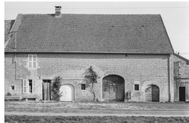
Ferme située à Publy. Phot. Bernard Pontefract IVR43_19763900315Z
