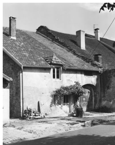
Ferme située à Perrigny. Phot. Dominique Dominguez IVR43_19803900186X
