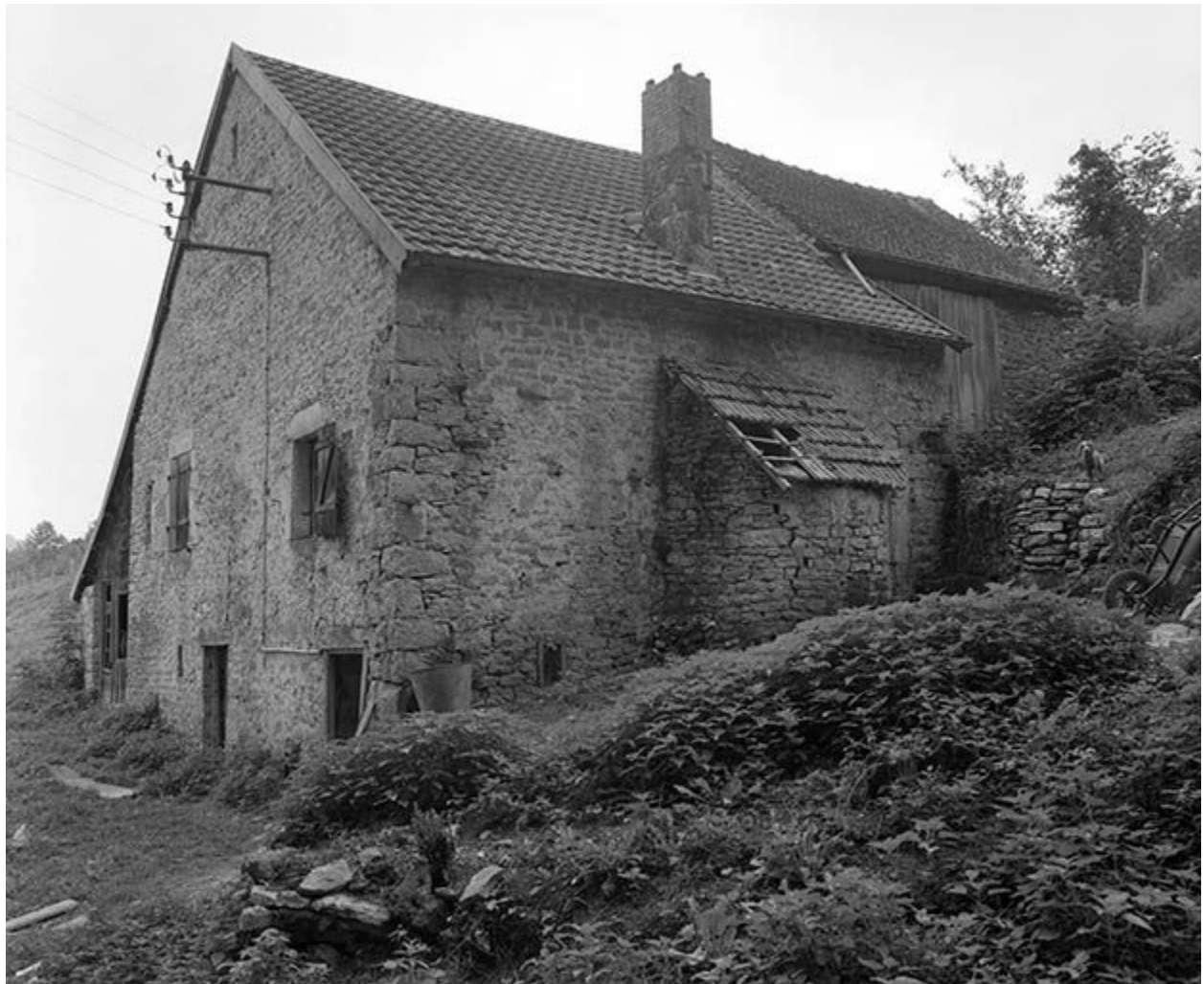
Façade antérieure et face latérale droite.
