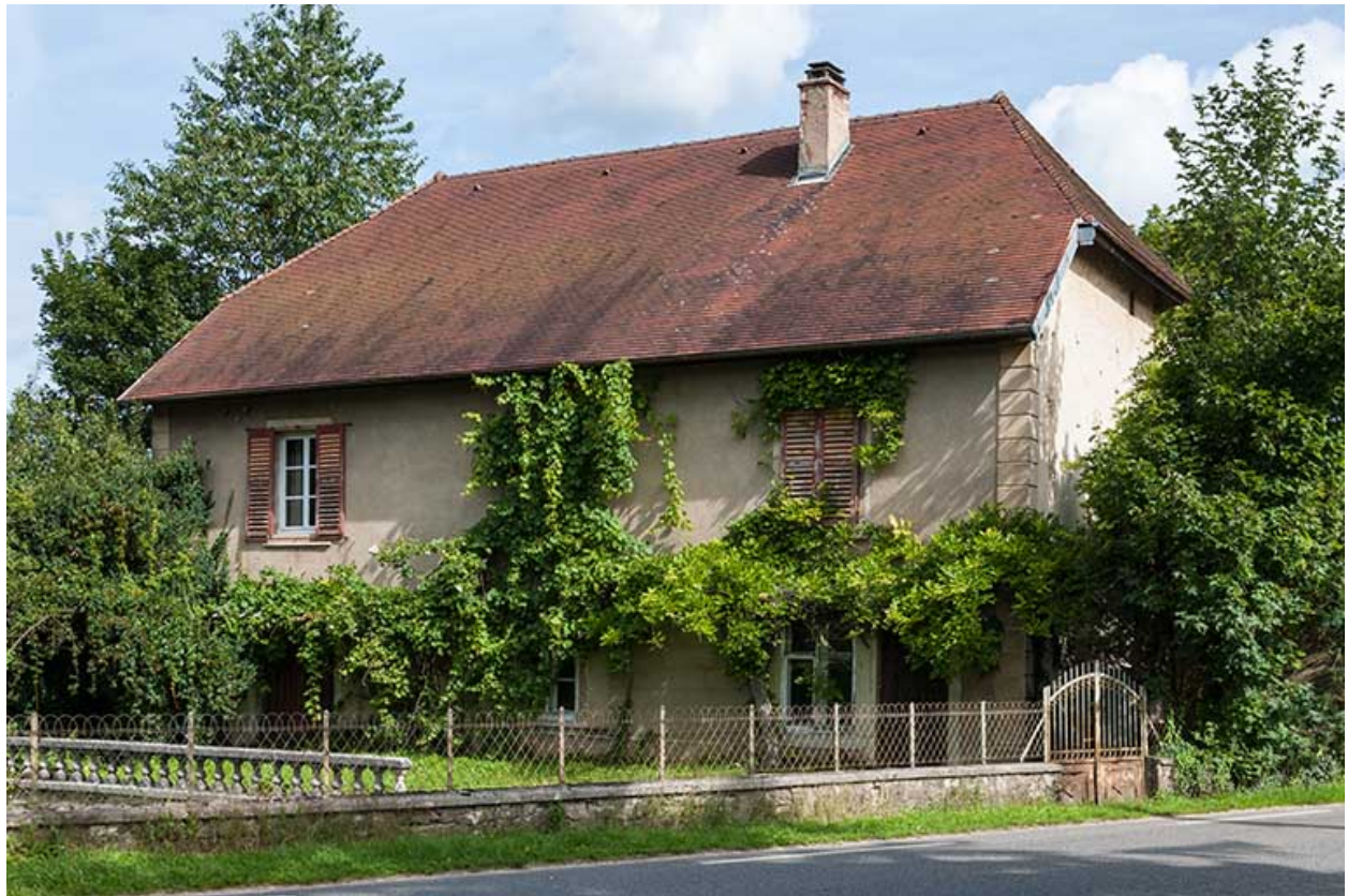
Façade sud : le logement.
