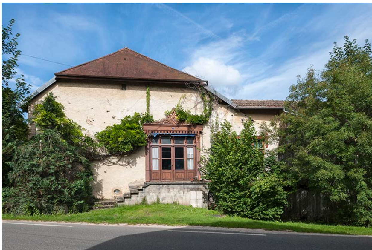
Façade sud de l'atelier.
