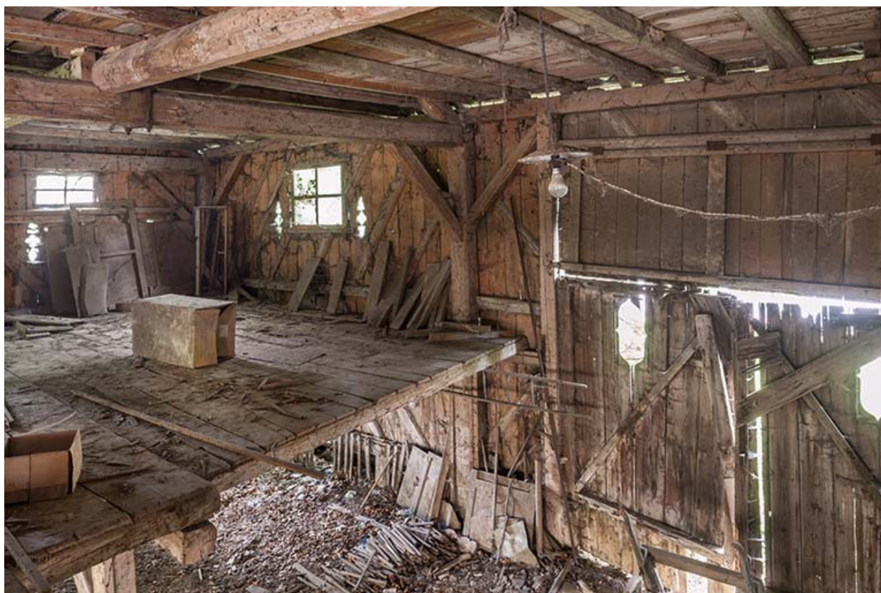
Magasin industriel. Vue depuis l'étage.
