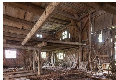
Magasin industriel. Vue depuis l'ouest. Phot. Jérôme Mongreville IVR43_20142501292NUC4A
