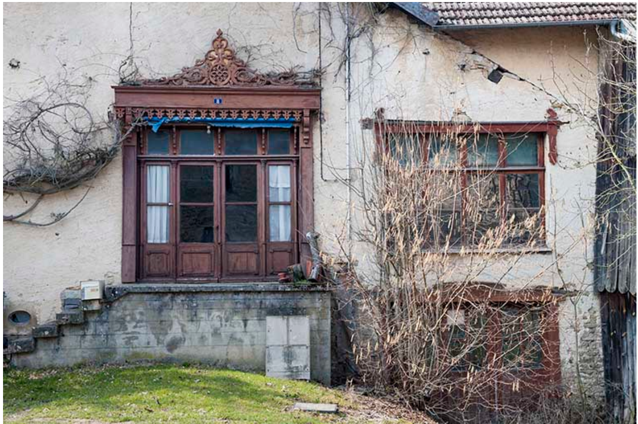
Façade sud. Entrées des ateliers.
