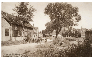
Rougemont (Doubs). Route de Vesoul. - L'Usine. S.d. [vers 1920]. Phot. Jérôme Mongreville, Autr. auteur inconnu IVR43_20102501410NUC4A
