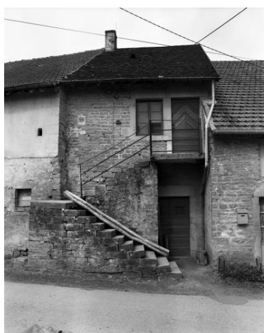
Maison de vigneron située rue Saint-Antoine. Phot. Yves Sancey IVR43_19813900247X
