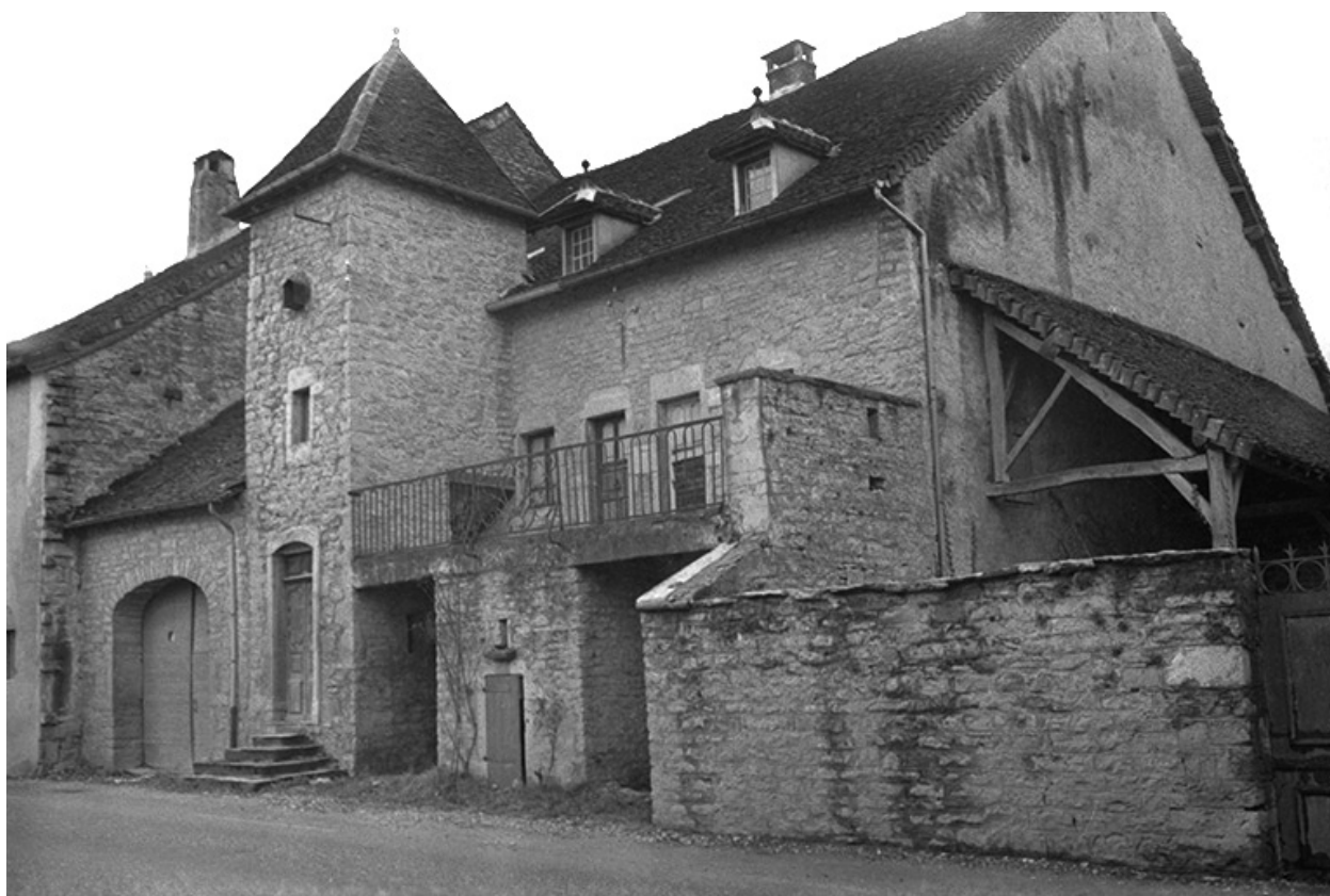
Maison du 17e ou du 18 siècle.
