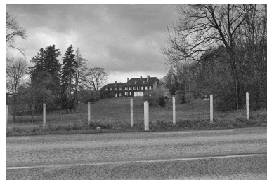
Maison du 19e siècle et son parc. Phot. Guy Forestier IVR43_19743900481Z
