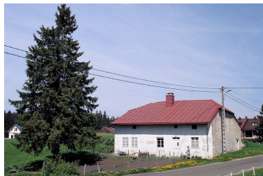
Vue générale. Phot. Yves Sancey IVR43_19993900081ZA
