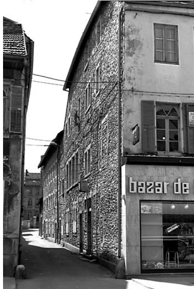
Façade sur la rue Thiers. Phot. Yves Sancey IVR43_19802500268X
