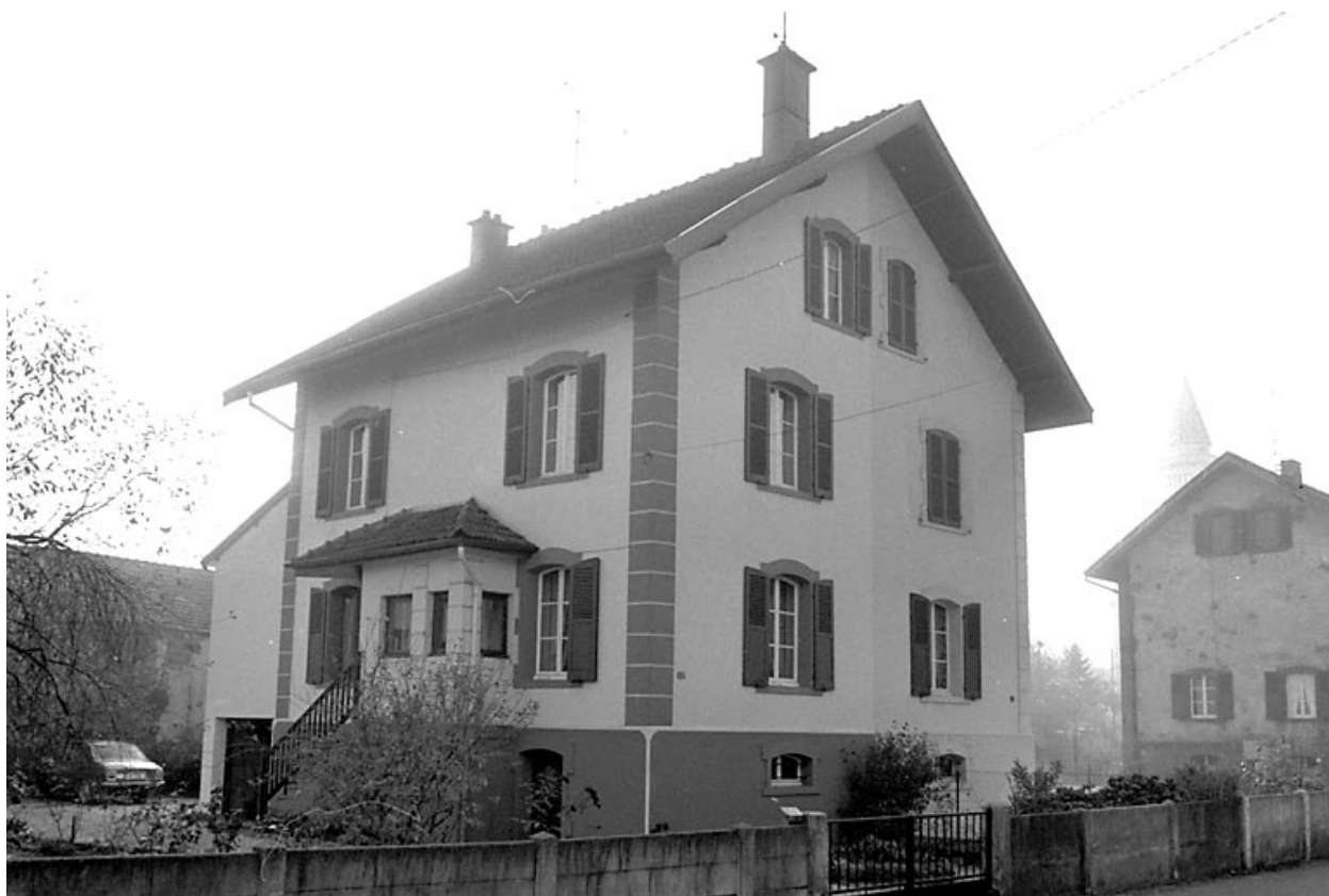
Façade antérieure vue de trois quarts gauche.
