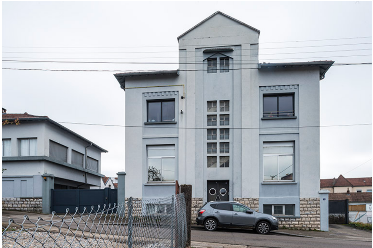
Façade antérieure (les bureaux).
