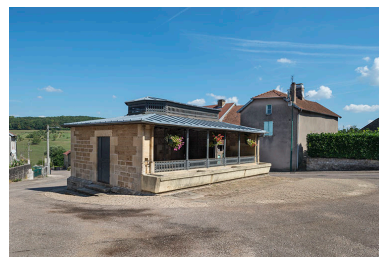
Le lavoir, rue du Vaux. Phot. Jérôme Mongreville IVR43_20177001322NUC4A
