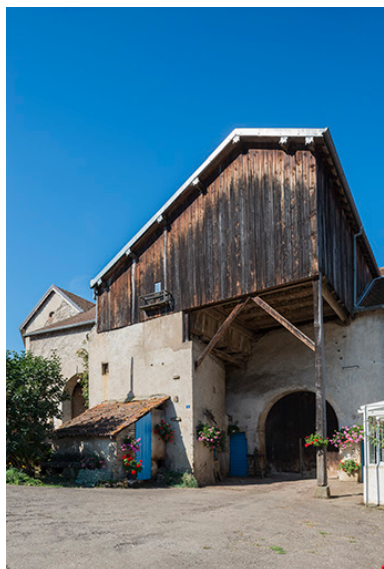
Entrée de grange, rue du Vaux. Phot. Jérôme Mongreville IVR43_20177001273NUC4A
