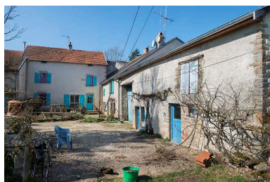
Les façades antérieures du moulin. Phot. Jérôme Mongreville IVR43_20187000151NUC4A
