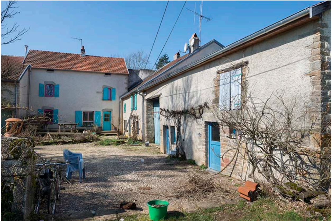
Les façades antérieures du moulin.
