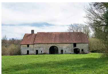
La ferme Saint-Jean. Phot. Jérôme Mongreville IVR43_20187000205NUC4A
