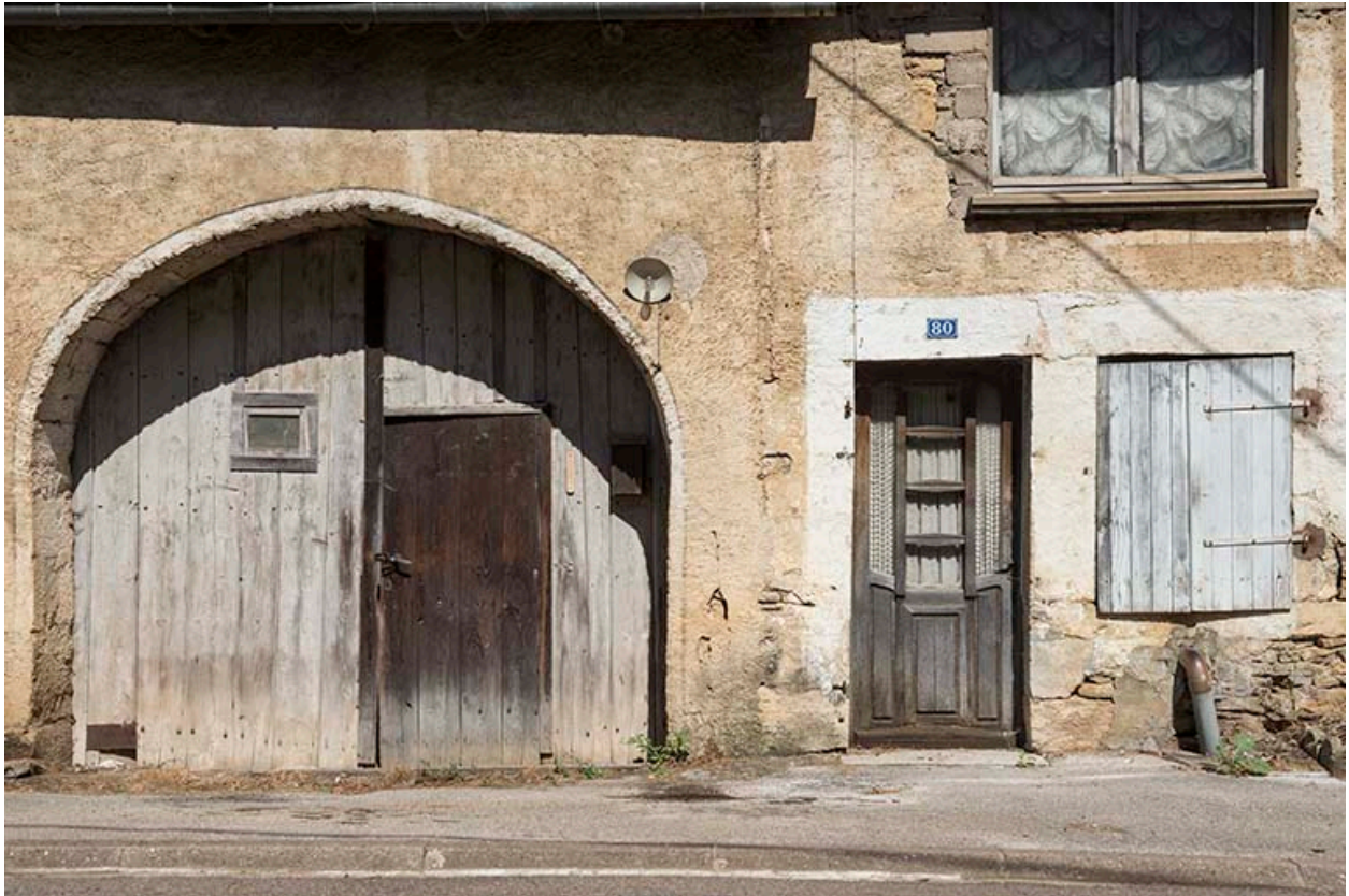
Ferme à deux travées, Grande rue.
