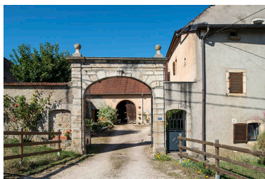
Portail d'une ferme, rue du Vaux. Phot. Jérôme Mongreville IVR43_20177001274NUC4A
