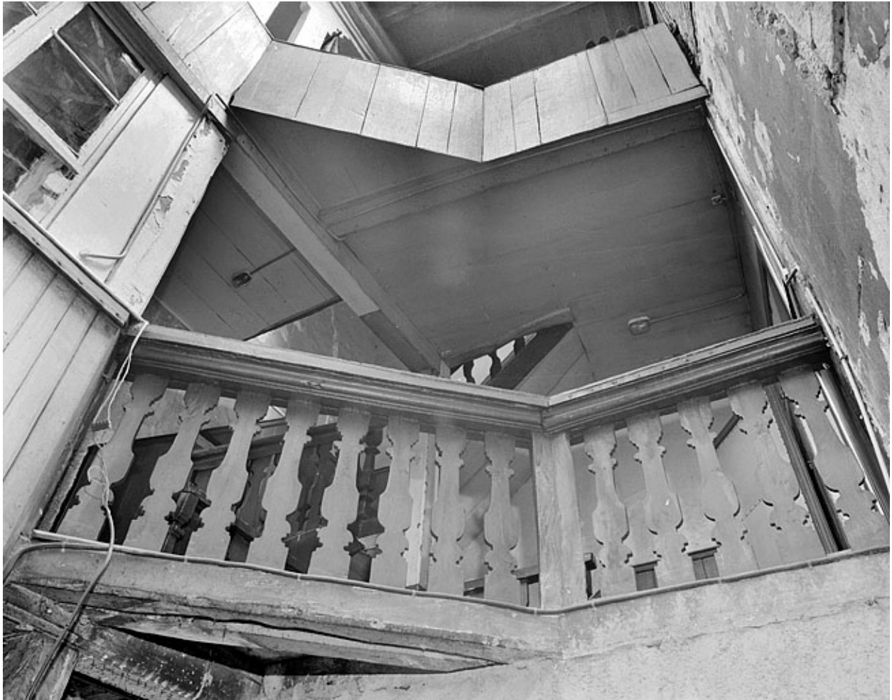
Escalier/galerie de liaison.
