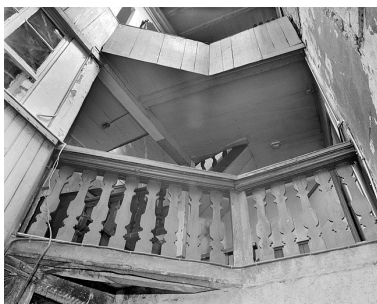
Escalier/galerie de liaison. Phot. Jérôme Mongreville IVR43_19872500904X
