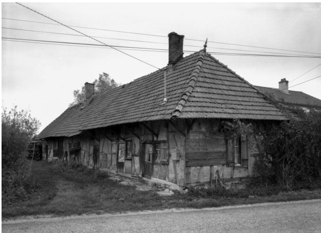
Vue d'une ferme au lieu-dit Vaulvry.
