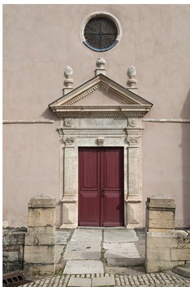
Le portail d'entrée. Phot. Jérôme Mongreville IVR43_20187000135NUC4A
