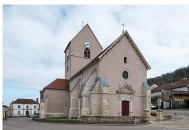
Vue depuis la place publique. Phot. Jérôme Mongreville IVR43_20187000131NUC4A
