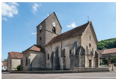
Vue avant restauration (2016). Phot. Jérôme Mongreville IVR43_20187000140NUC4A
