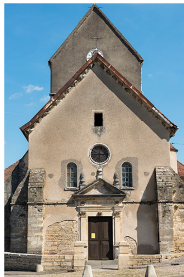
Vue avant restauration (2016). Phot. Jérôme Mongreville IVR43_20187000142NUC4A
