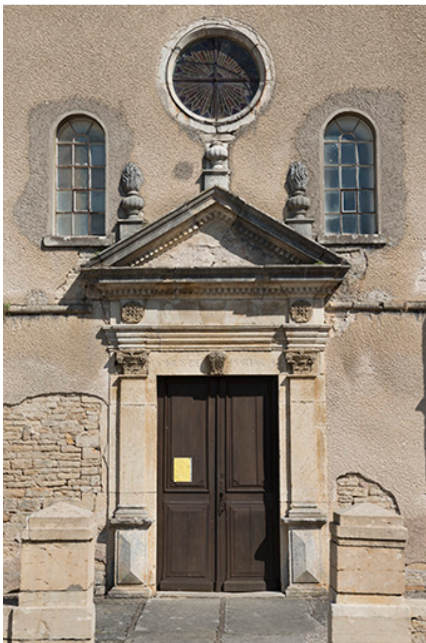
Vue avant restauration (2016).
