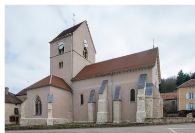
Vue latérale depuis la Grande rue. Phot. Jérôme Mongreville IVR43_20187000132NUC4A
