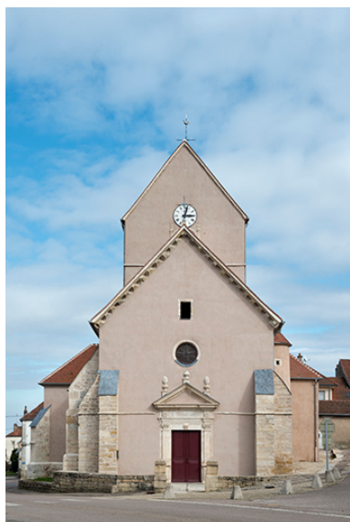
La façade occidentale. Phot. Jérôme Mongreville IVR43_20187000133NUC4A
