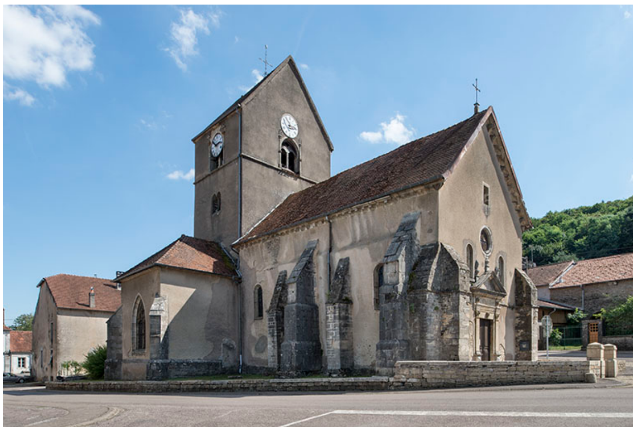
Vue avant restauration (2016).
