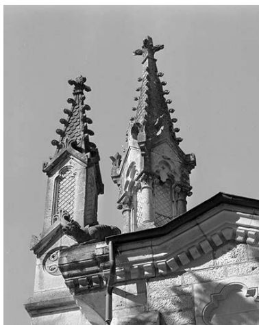
Façade antérieure, détail : les clochetons. Phot. Jérôme Mongreville IVR43_20002500071X
