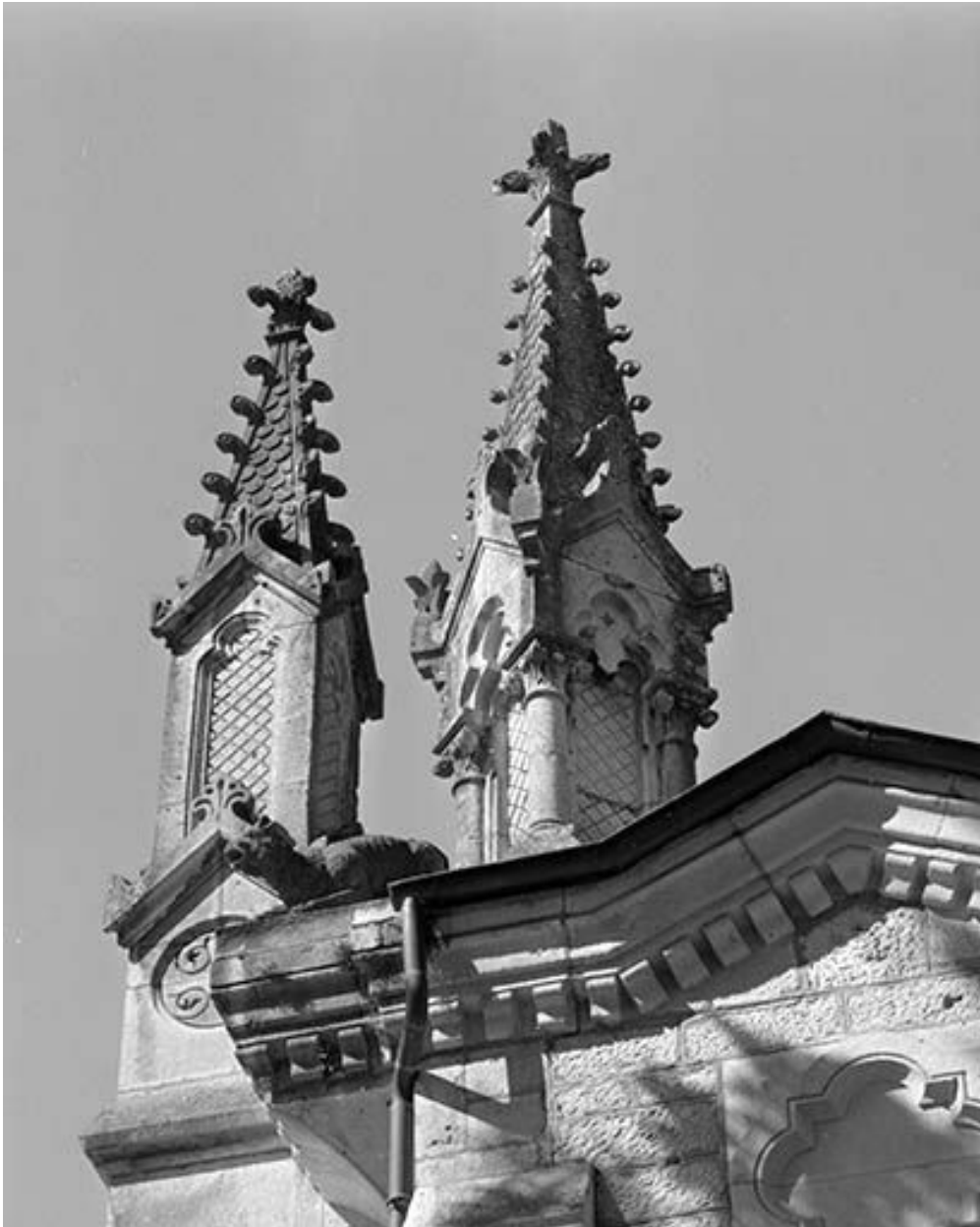
Façade antérieure, détail : les clochetons.
