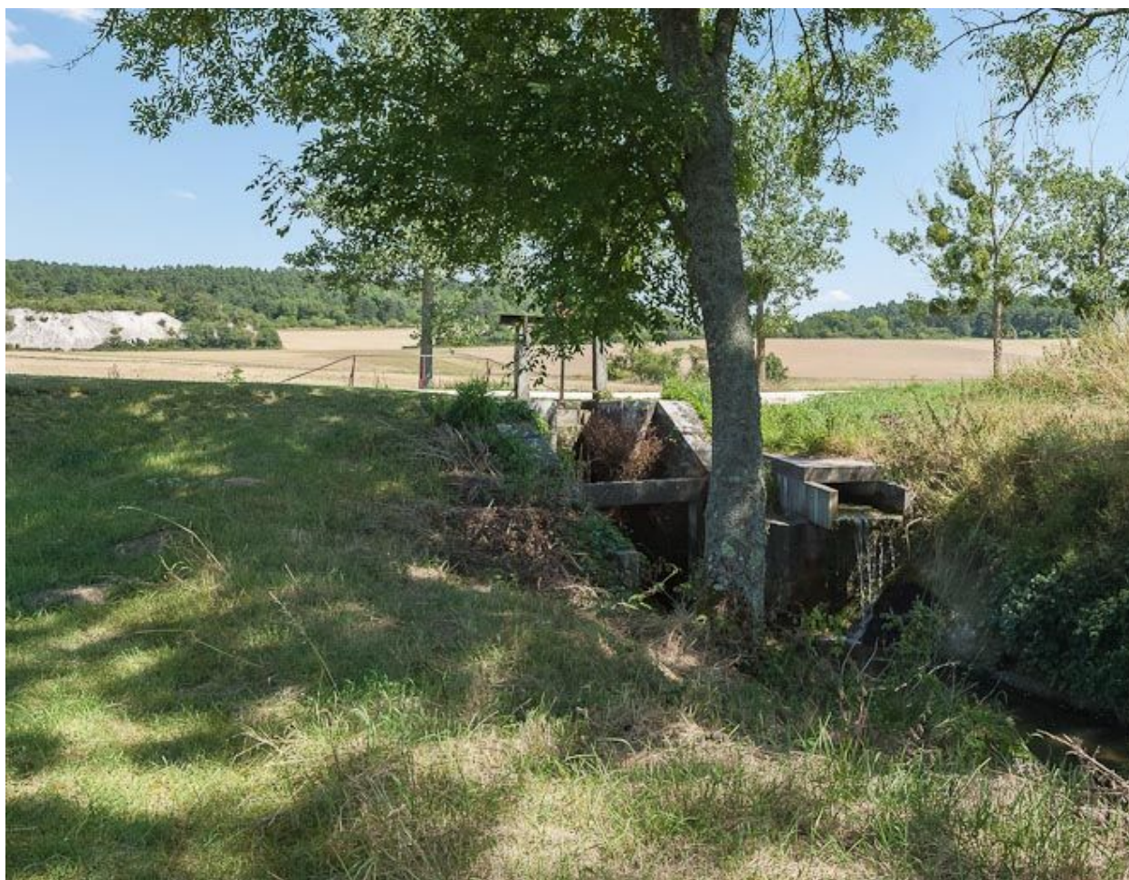
Déversoir avec vanne rive gauche.
