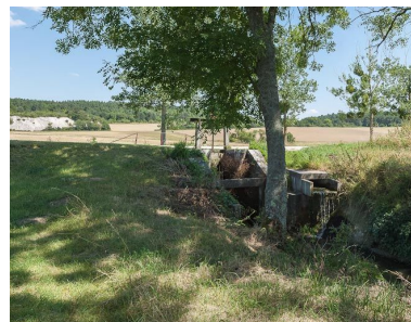
Déversoir avec vanne rive gauche. Phot. Pierre-Marie Barbe-Richaud IVR26_20128900372NUC2AQ
