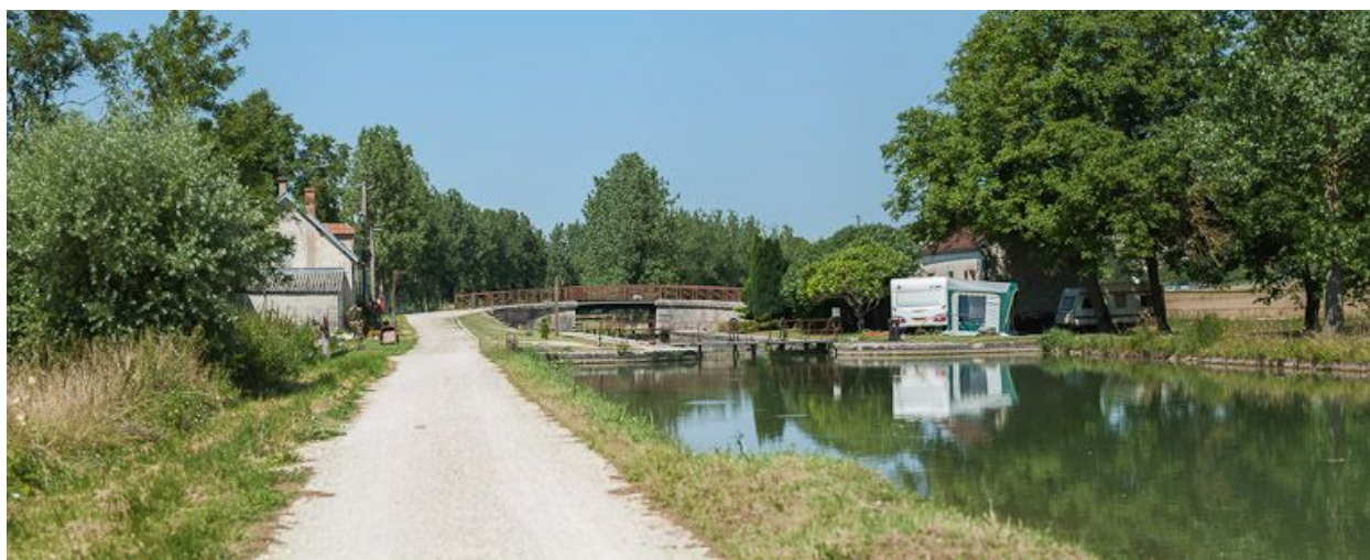
Site d'écluse vu d'amont.
