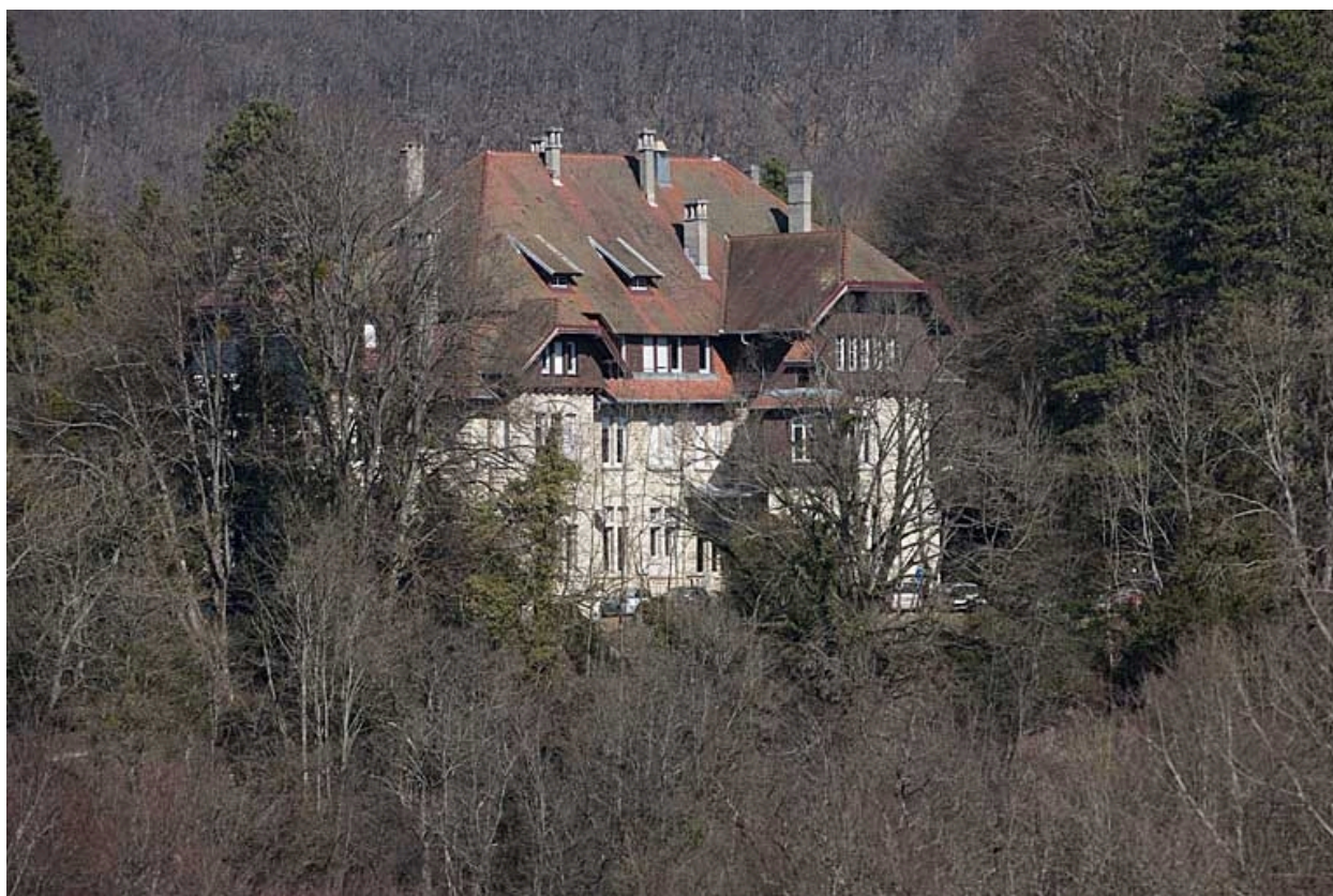
Vue éloignée depuis le sud-ouest.
