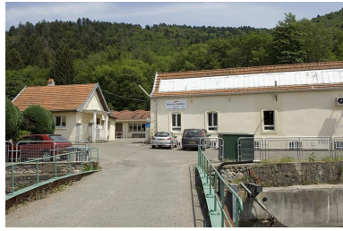
Vue d'ensemble depuis l'entrée du site. Phot. Jérôme Mongreville IVR43_20067000555NUCA
