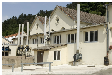
Anciennes chaufferie et salle des machines. Phot. Jérôme Mongreville IVR43_20067000563NUCA
