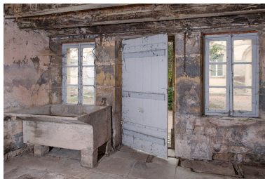
Intérieur de la buanderie. Phot. Jérôme Mongreville IVR43_20127000515NUC4A
