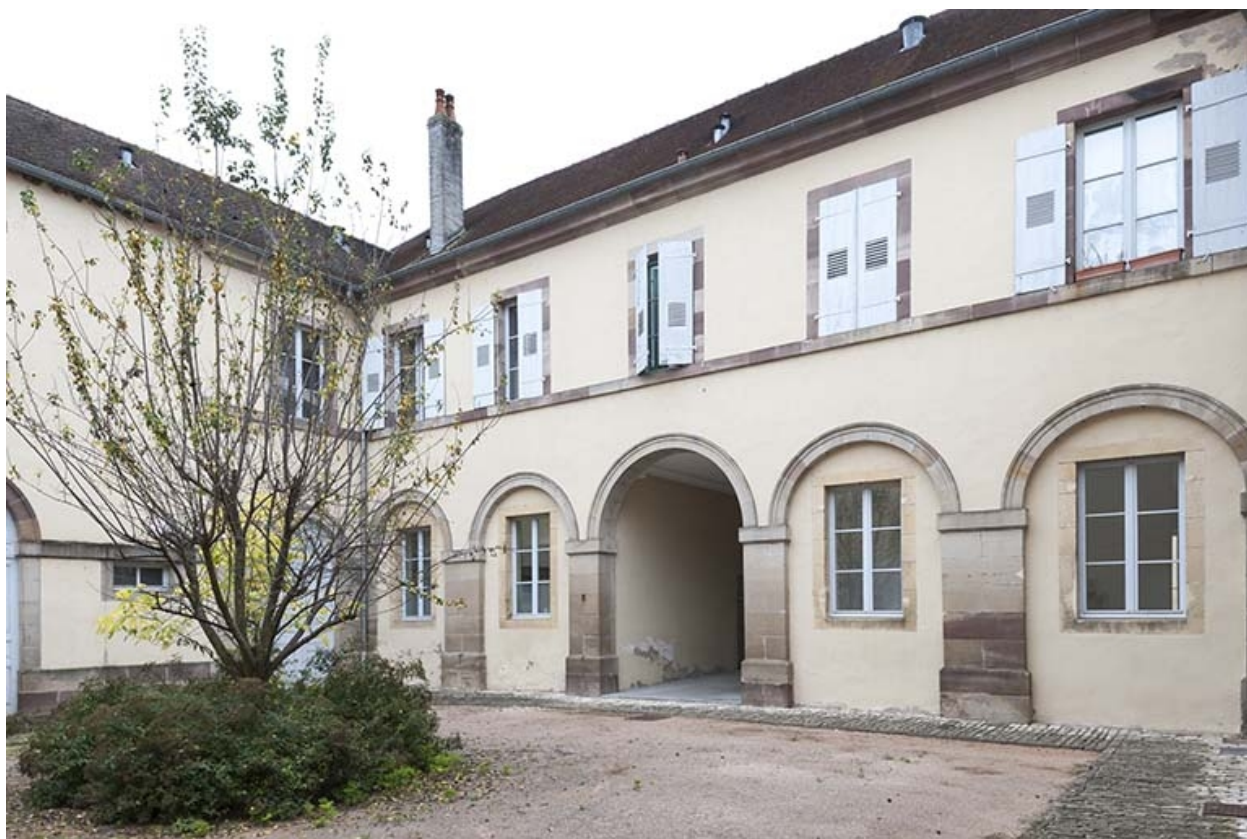
Façade postérieure et aile sud.
