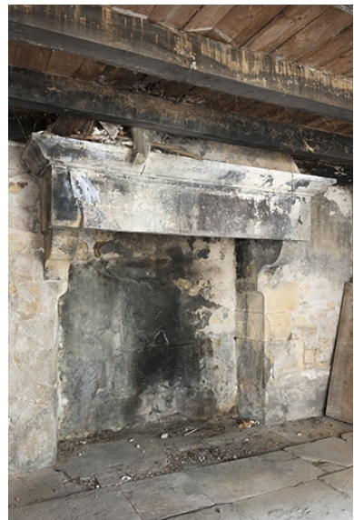
Intérieur de la buanderie : cheminée. Phot. Jérôme Mongreville IVR43_20127000363NUC4A
