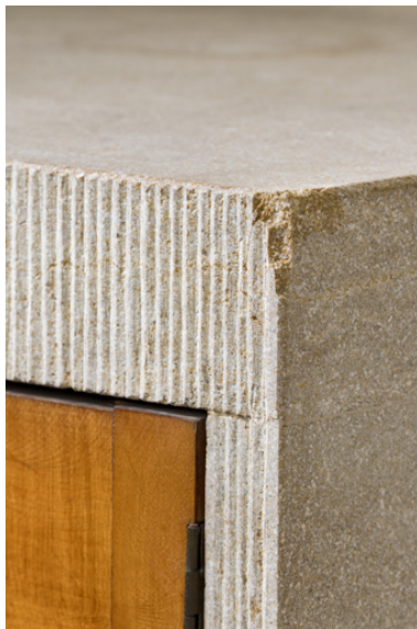
Détail du tabernacle. Phot. Pierre-Marie Barbe-Richaud IVR26_20238901233NUC4A
