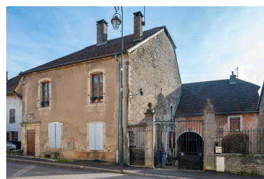
Vue générale. Phot. Jérôme Mongreville IVR43_20197000118NUC4A
