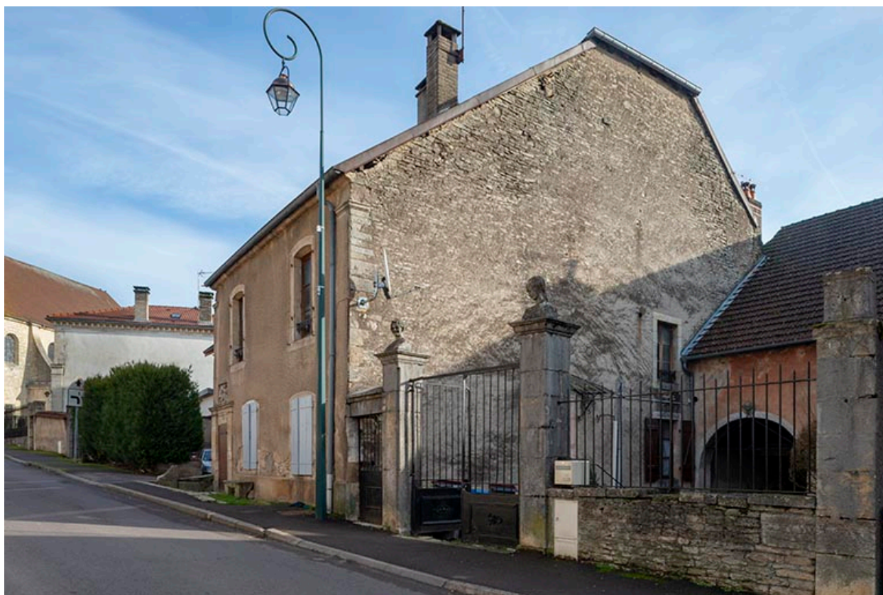
Vue de trois-quarts depuis le sud-ouest.
