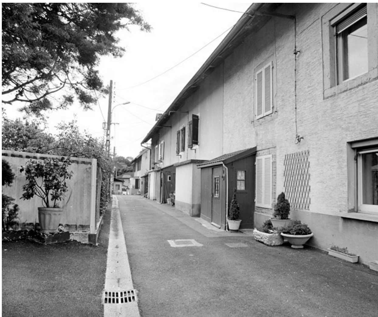
Façades est rue des Bouleaux.
