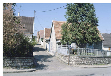
Alignement de maisons rue des Mélèzes en 1986. Phot. Yves Sancey IVR43_19869000031XA
