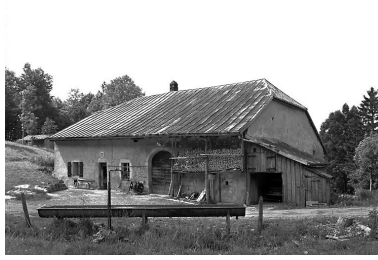
Ferme située au lieudit La Combe des Cives. Phot. Yves Sancey IVR43_19782500431X
