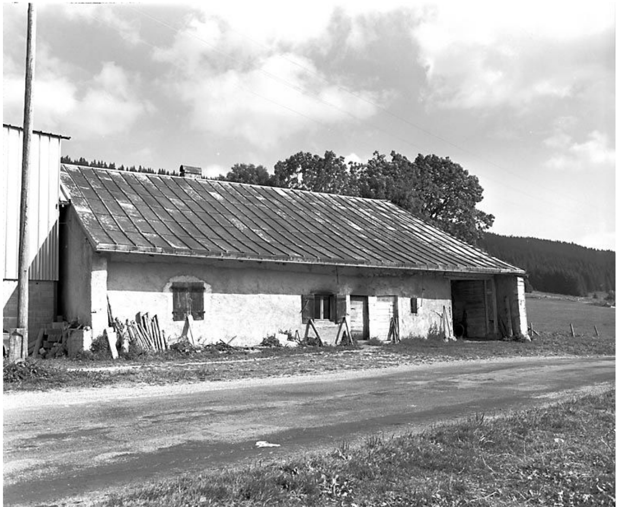
Ferme située au lieudit La Combe des Cives.
