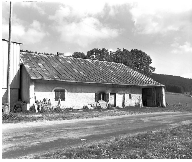
Ferme située au lieudit La Combe des Cives. Phot. Yves Sancey IVR43_19782500393X
