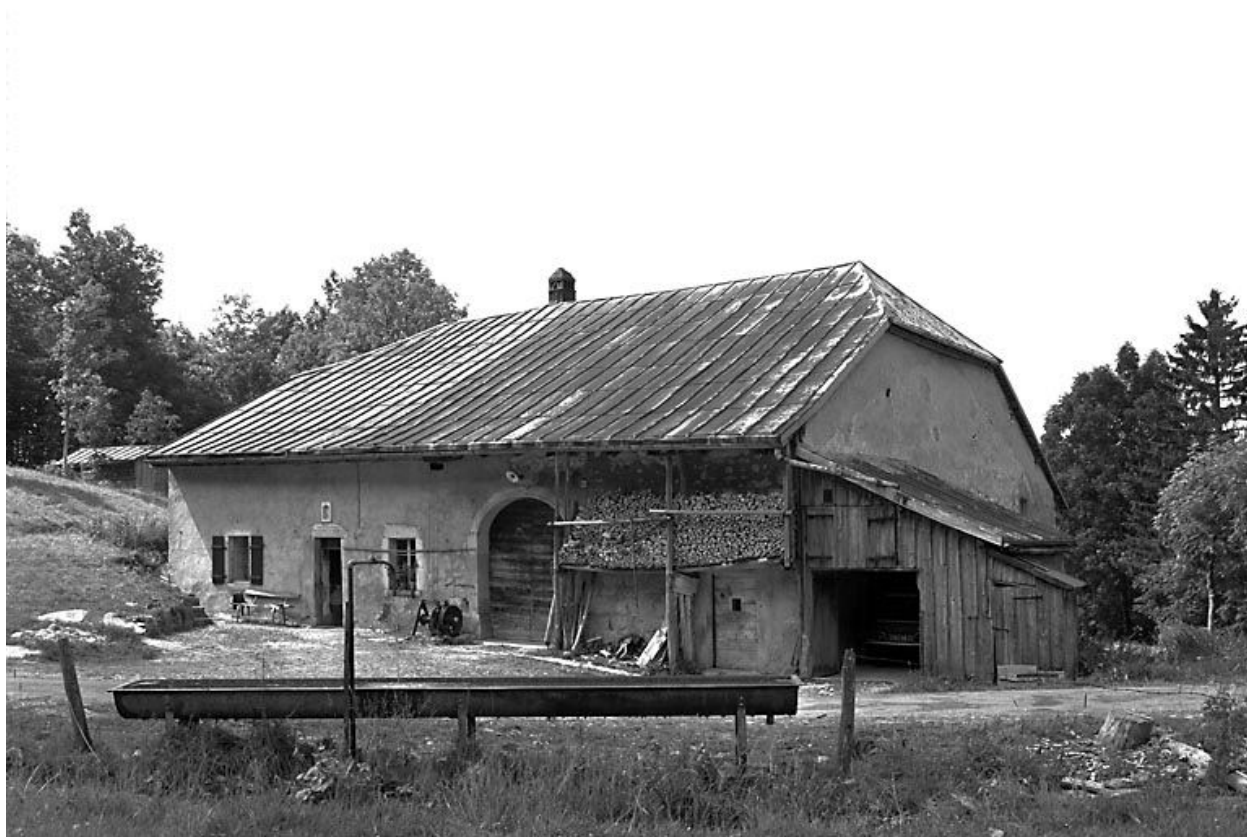
Ferme située au lieudit La Combe des Cives.
