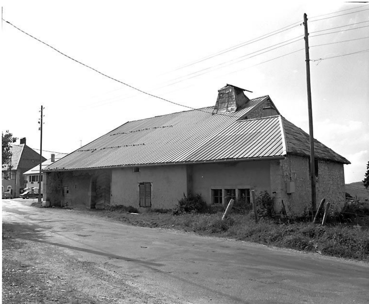
Ferme située 11 rue Principale.
