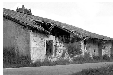
Ferme située au lieudit La Combe des Cives. Phot. Gilbert Poinot IVR43_19752500939Z
