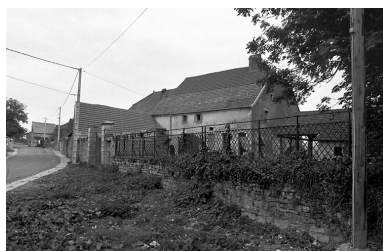
Vue d'ensemble. Phot. Bernard Lardière IVR43_19797000207Z
