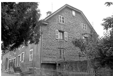
Façades antérieure et latérale droite.
