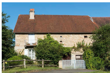
Façade sur rue Phot. Sonia Dourlot IVR43_20167001114NUC4A
