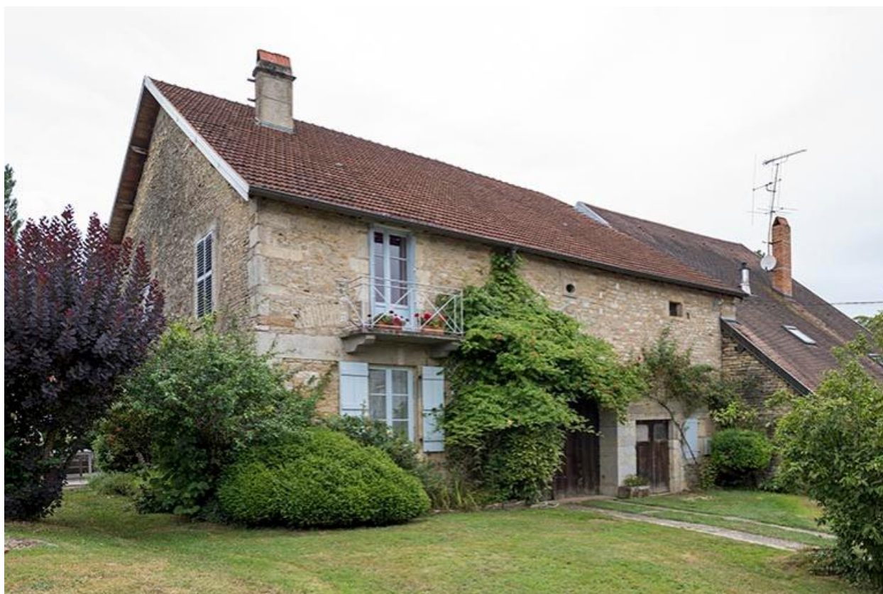
Façade sur rue de trois-quart
