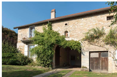
Façade sur rue Phot. Sonia Dourlot IVR43_20167001455NUC4A
