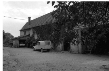
Bâtiment de droite : façade sur cour. Phot. Bernard Lardière IVR43_19797000038Z
