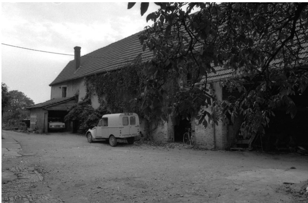
Bâtiment de droite : façade sur cour.
