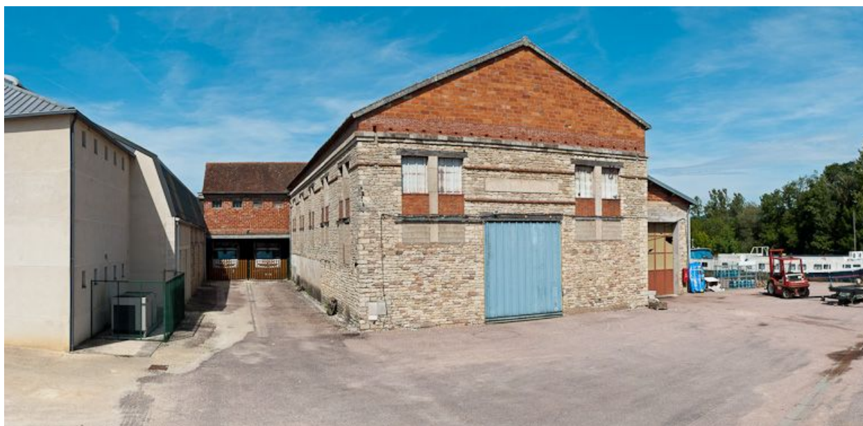
Vue de l'ancienne usine à chaux.
