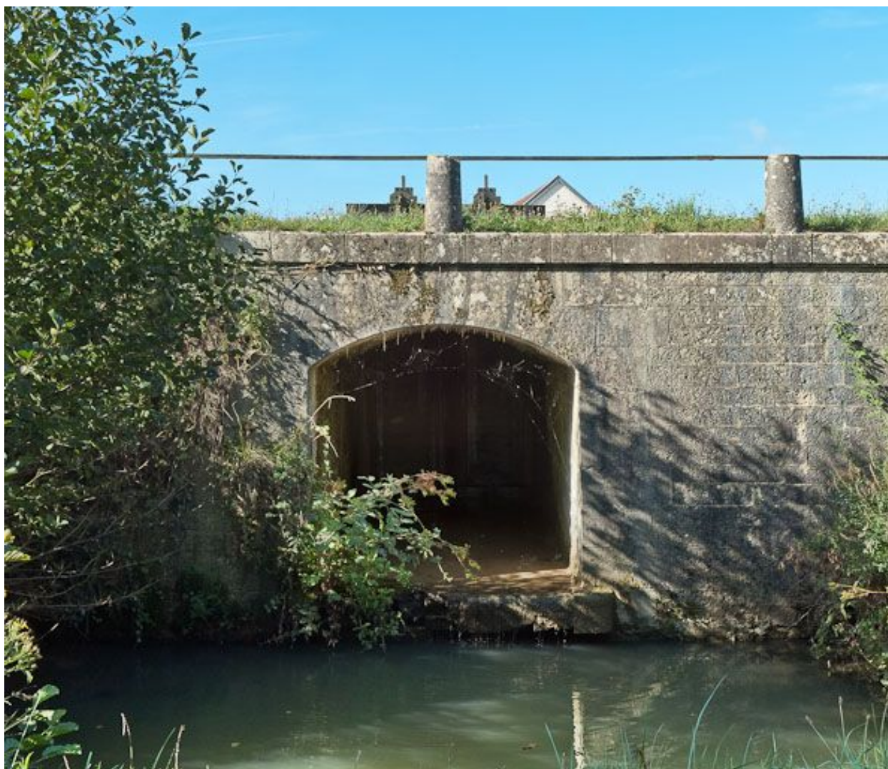
Vue de l'aqueduc.
