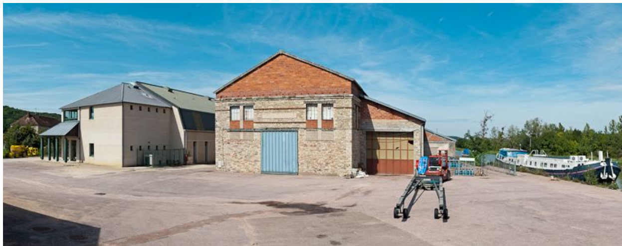
Vue de l'ancienne usine à chaux.
