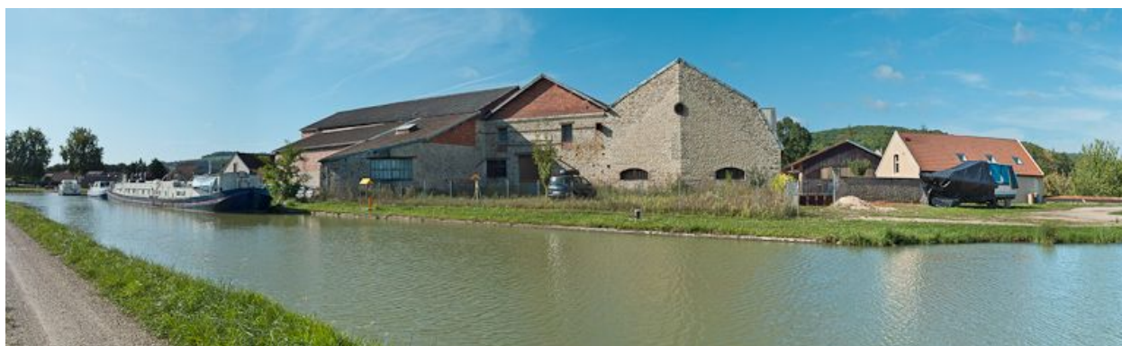
Vue de l'ancienne usine à chaux.
