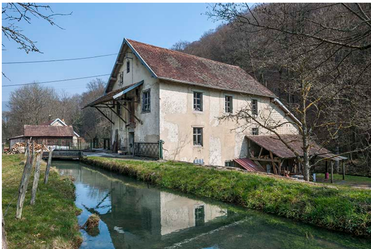
Le moulin et son canal d'amenée.
