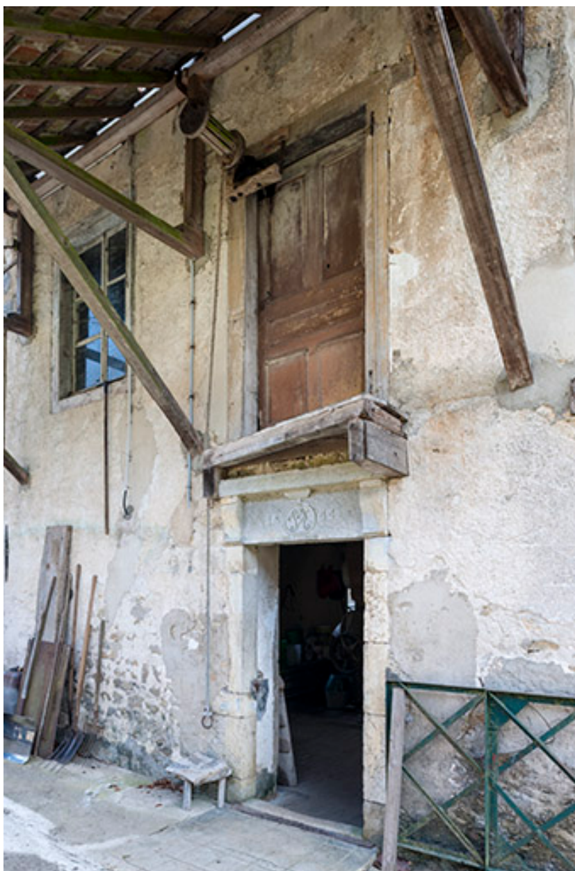
Mur-pignon ouest vu de trois quarts.
