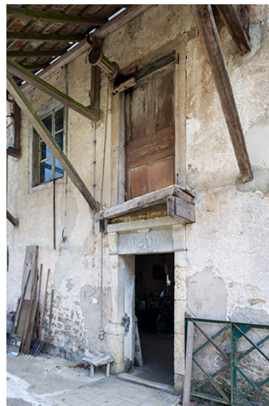
Mur-pignon ouest vu de trois quarts. Phot. Jérôme Mongreville IVR43_20152500415NUC4A
