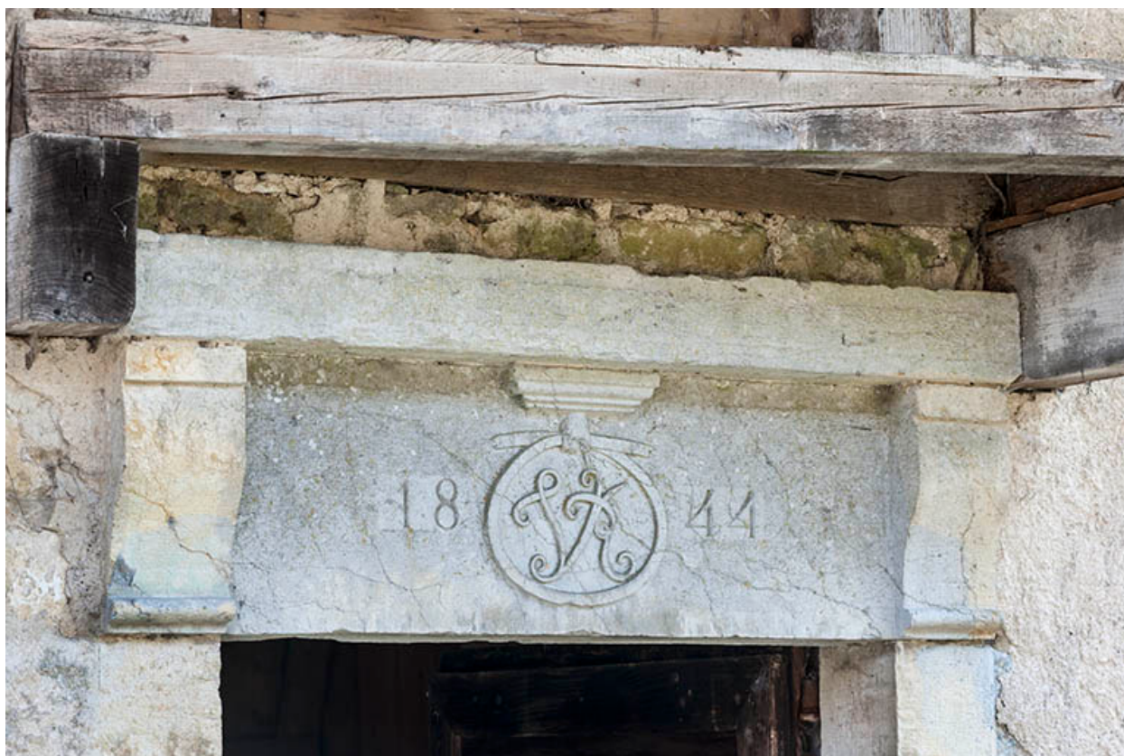
Mur-pignon ouest. Détail du linteau.
