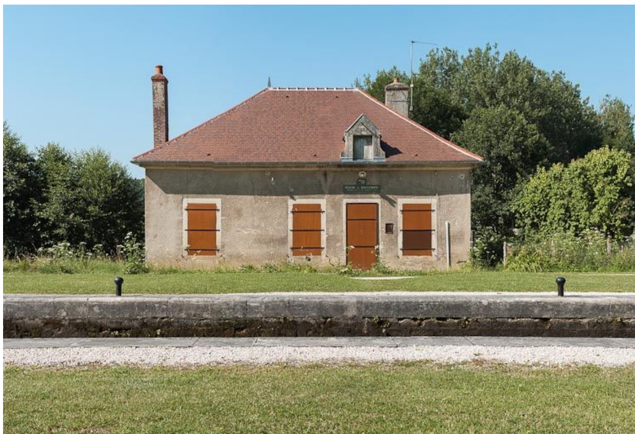
Maison éclusière vue de face.
