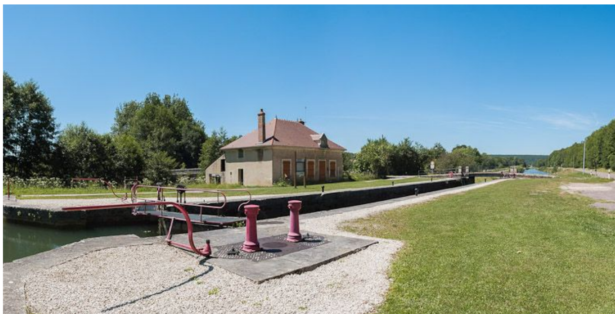
Le site d'écluse vu d'amont.
