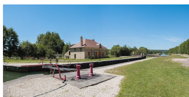
Le site d'écluse vu d'amont. Phot. Pierre-Marie Barbe-Richaud IVR26_20122101992NUC4AQ
