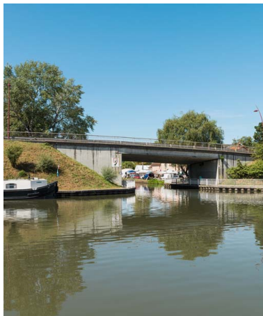
Vue générale du pont. Phot. Pierre-Marie Barbe-Richaud IVR26_20177100235NUC2A
