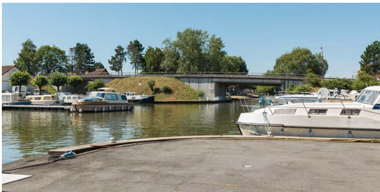
Vue générale du site et du pont.
