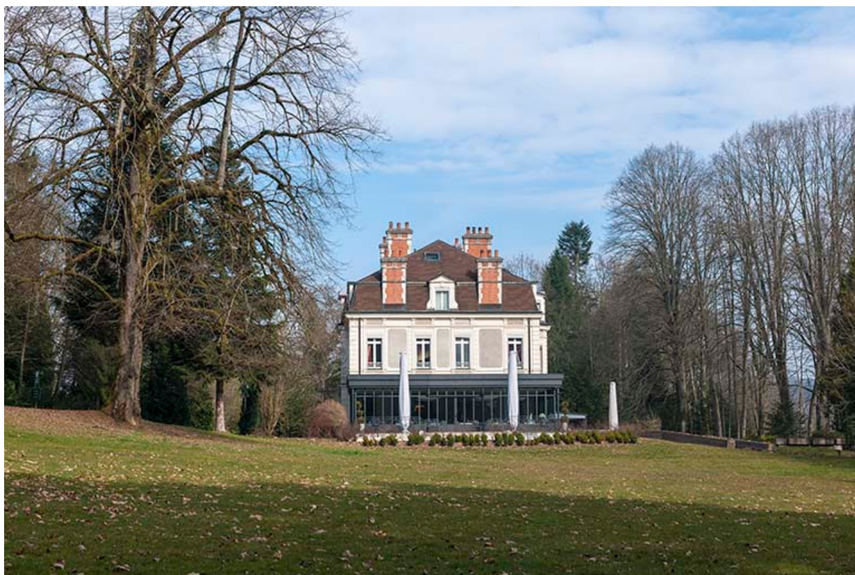
Logement patronal. Façade sud depuis le parc.
