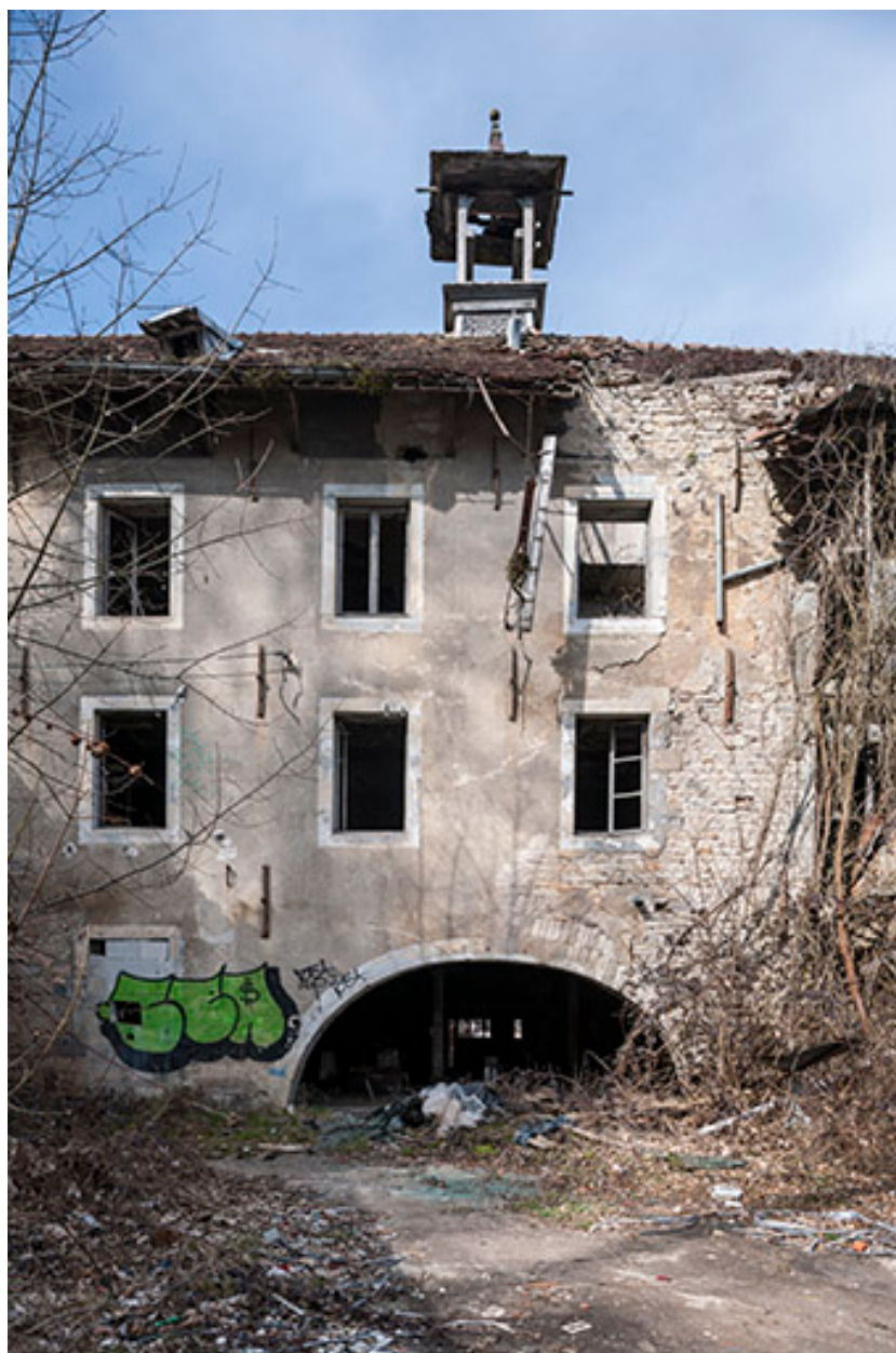
Façade sud de l'atelier principal.
