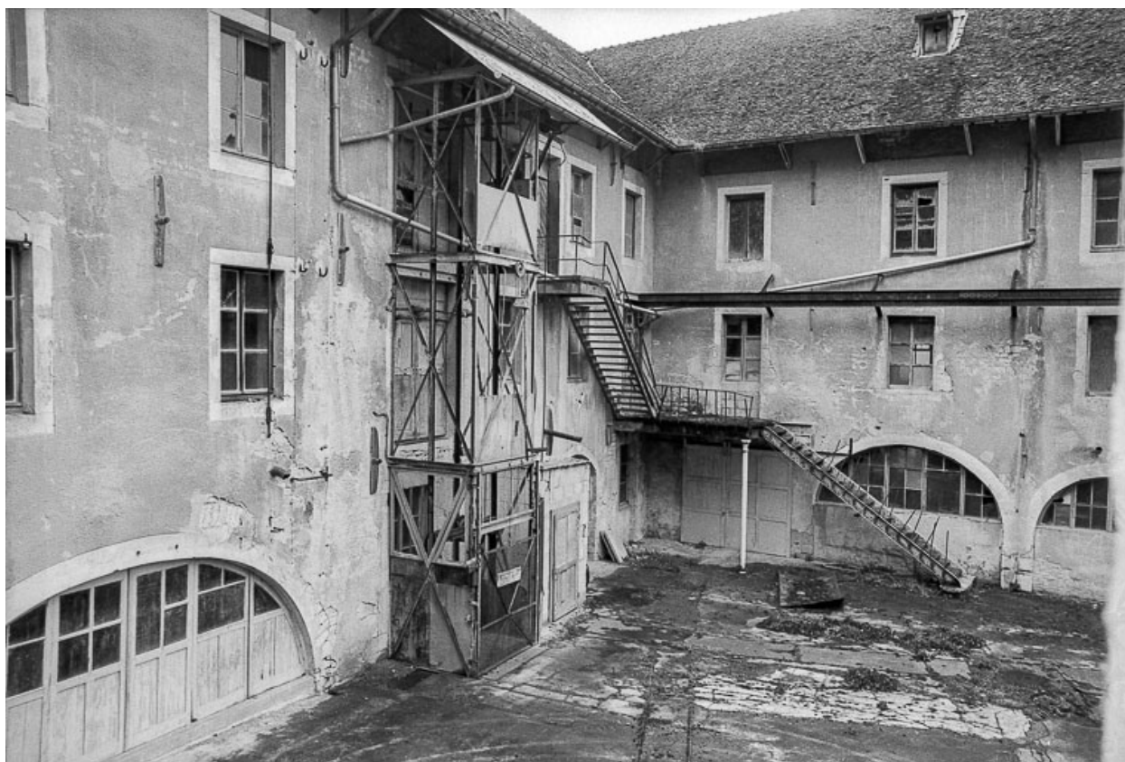
Atelier de fabrication primitif de la papeterie en 1979.
