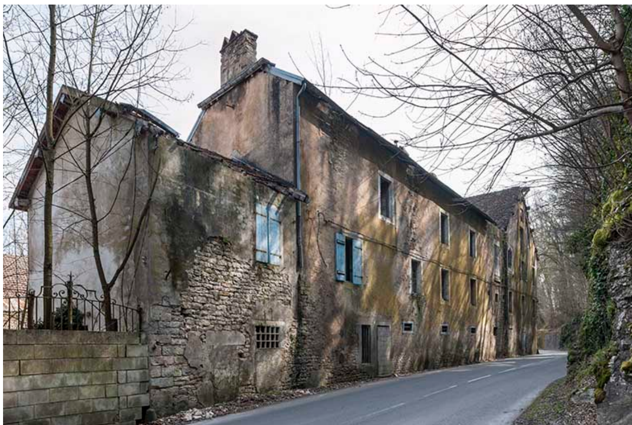
Bâtiment d'entrée longeant la route (logements).
