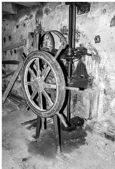
Mécanisme d'admission d'une turbine (?) en 1979. Phot. J. Dumont IVR43_19792501136Z
