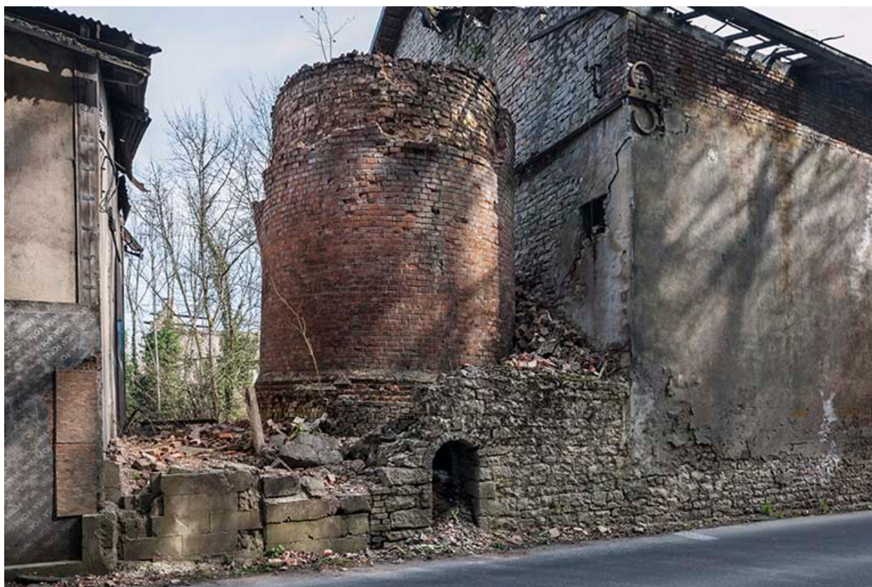
Base de la cheminée et la chaufferie.
