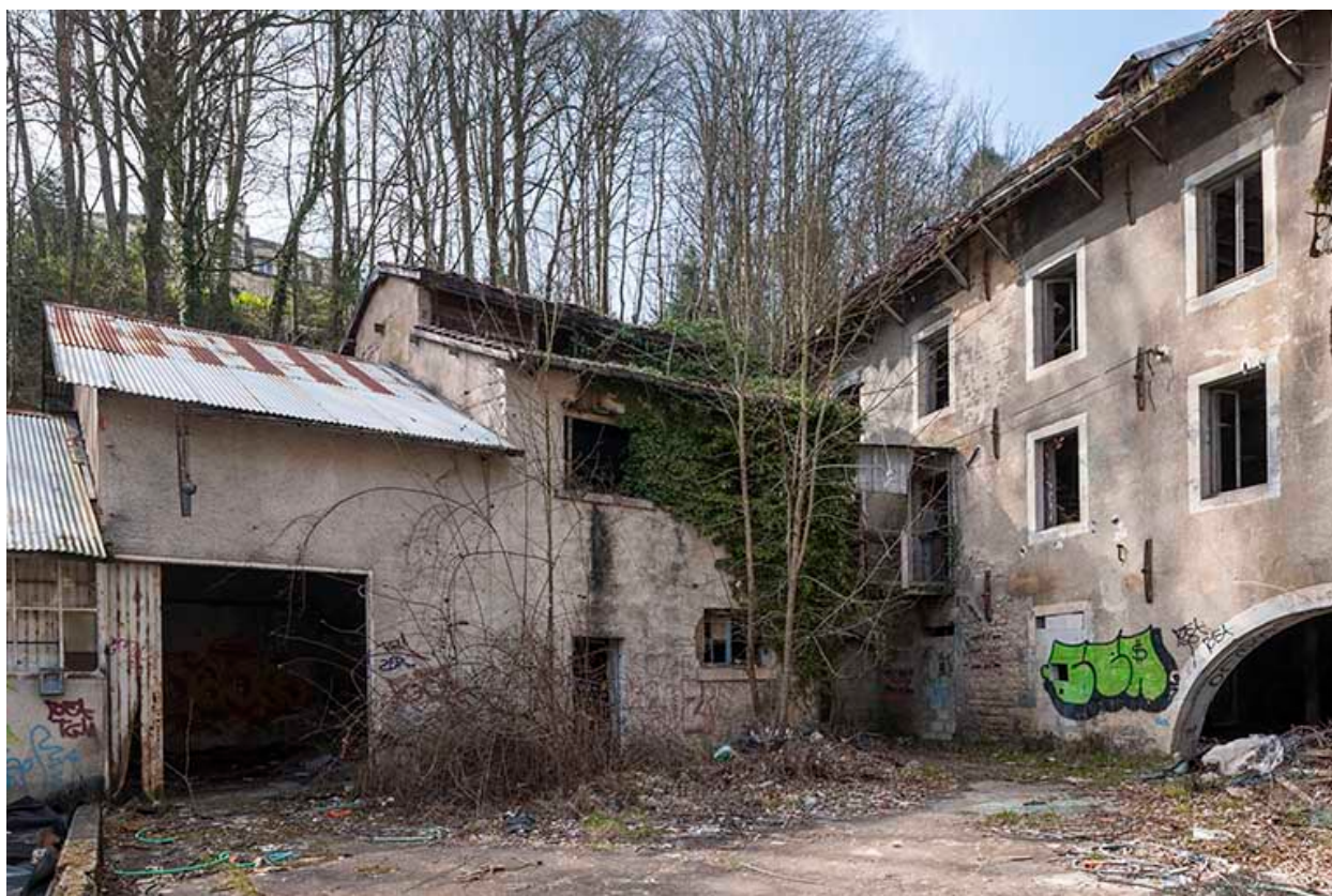
Atelier de blanchiment et bâtiment d'entrée.
