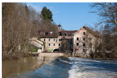
Vue depuis la rive droite du barrage. Phot. Jérôme Mongreville IVR43_20152500371NUC4A
