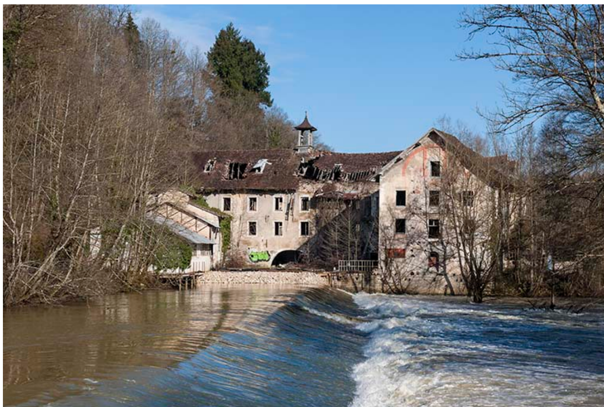
Vue depuis la rive droite du barrage.
