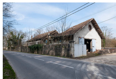
Magasin industriel (nord). Phot. Jérôme Mongreville IVR43_20152500379NUC4A
