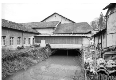
Canal de fuite principal en 1979. Phot. J. Dumont IVR43_19792501124Z
