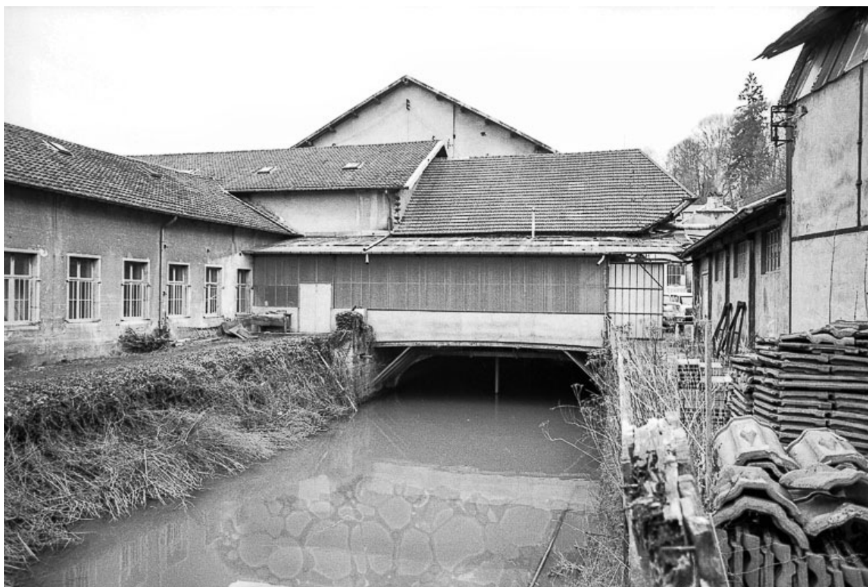
Canal de fuite principal en 1979.
