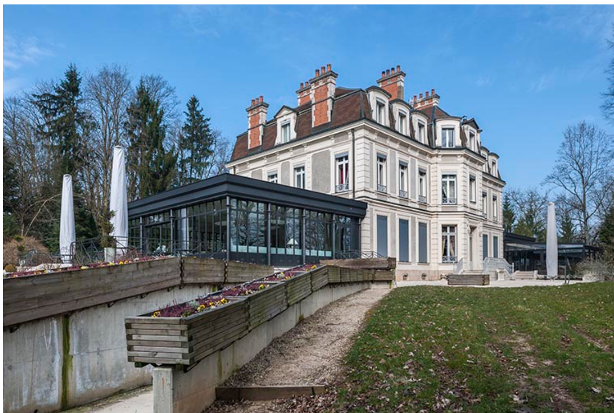
Logement patronal. Vue d'ensemble depuis le sud.
