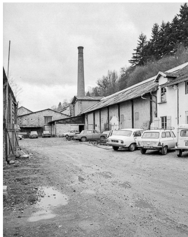
Magasins industriels au nord du site en 1979. Phot. J. Dumont IVR43_19792501128Z
