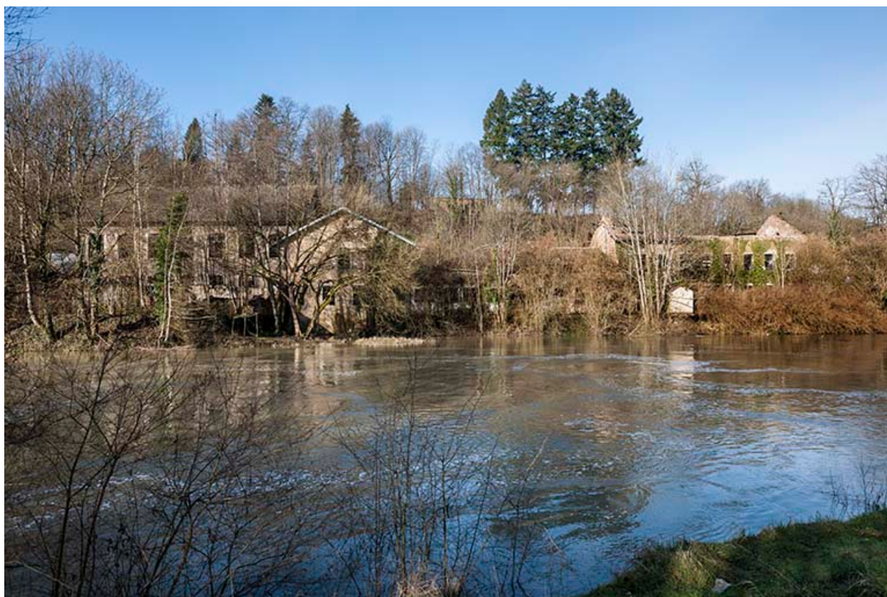
Vue d'ensemble depuis la rive droite.
