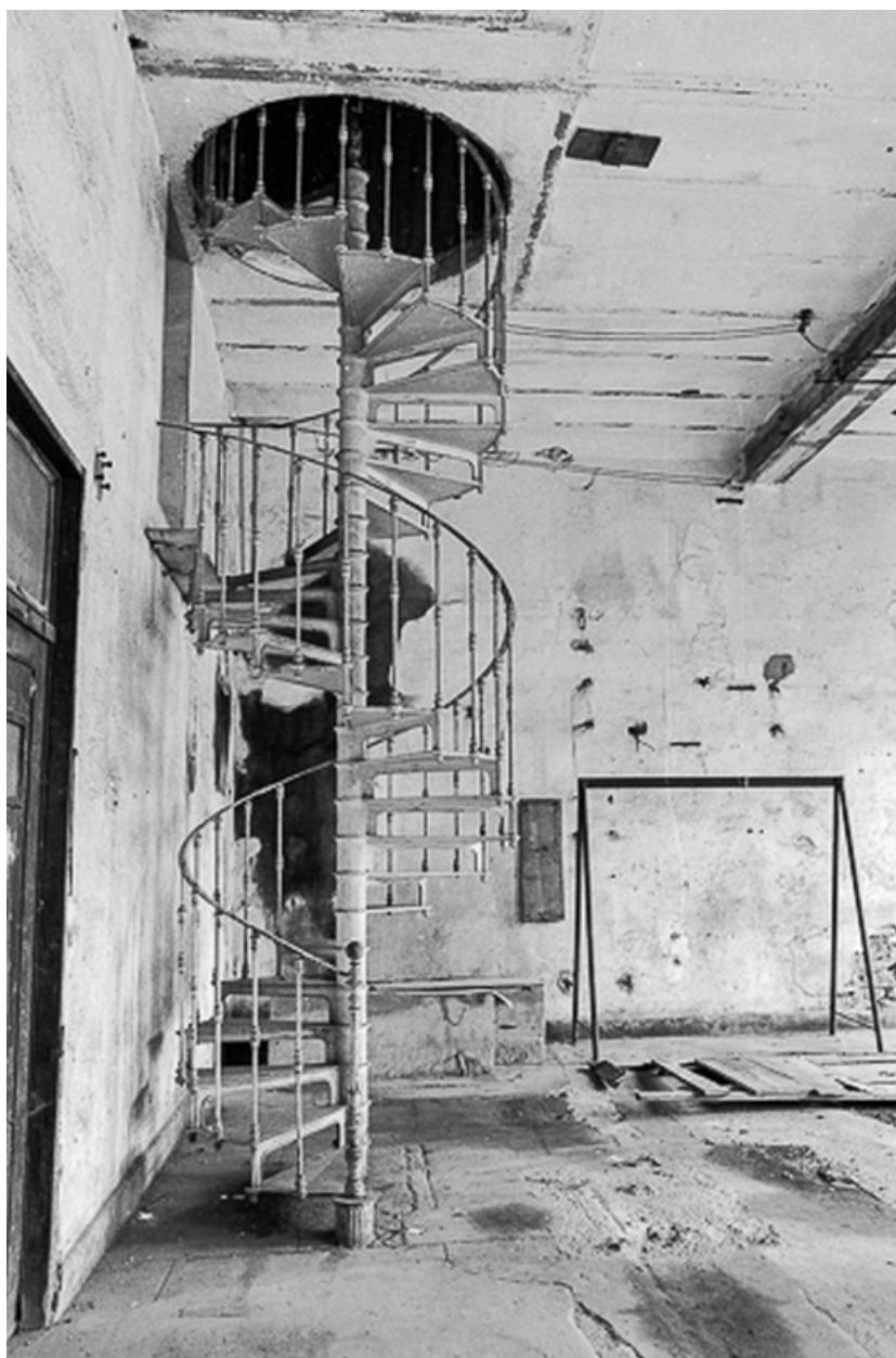
Vue intérieure en 1979. Escalier métallique.
