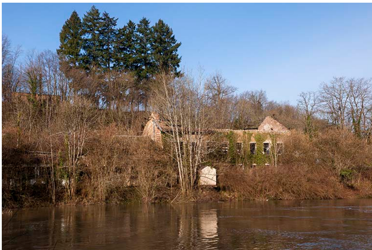
Atelier de fabrication incendié.
