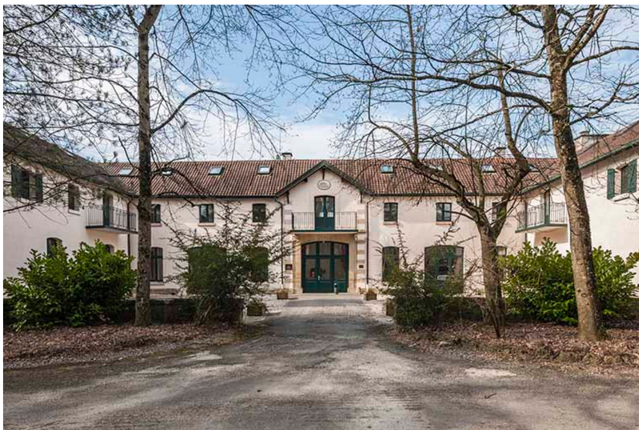
Bâtiment des communs. Vue axiale.
