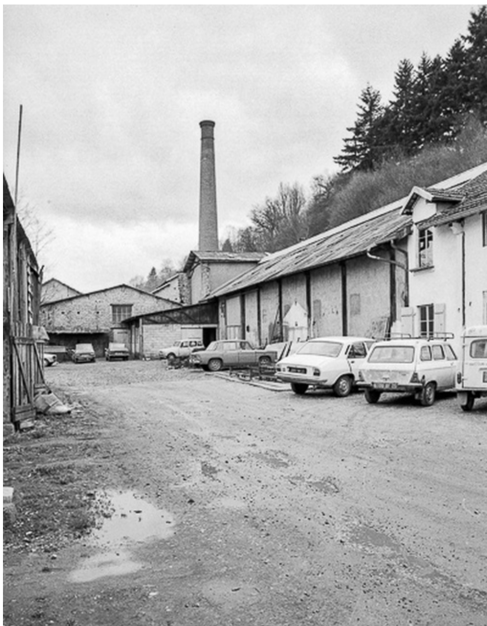
Magasins industriels au nord du site en 1979.
