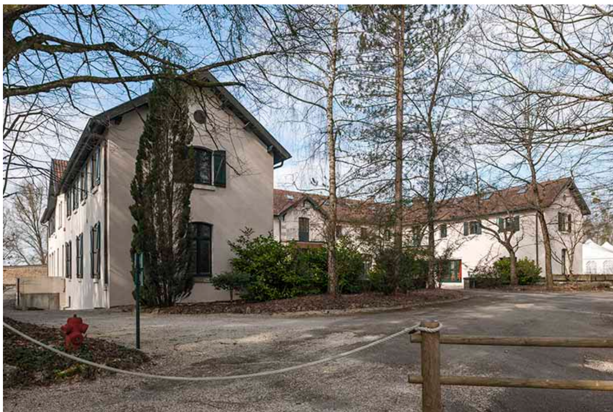
Bâtiment des communs. Vue depuis le sud-est.
