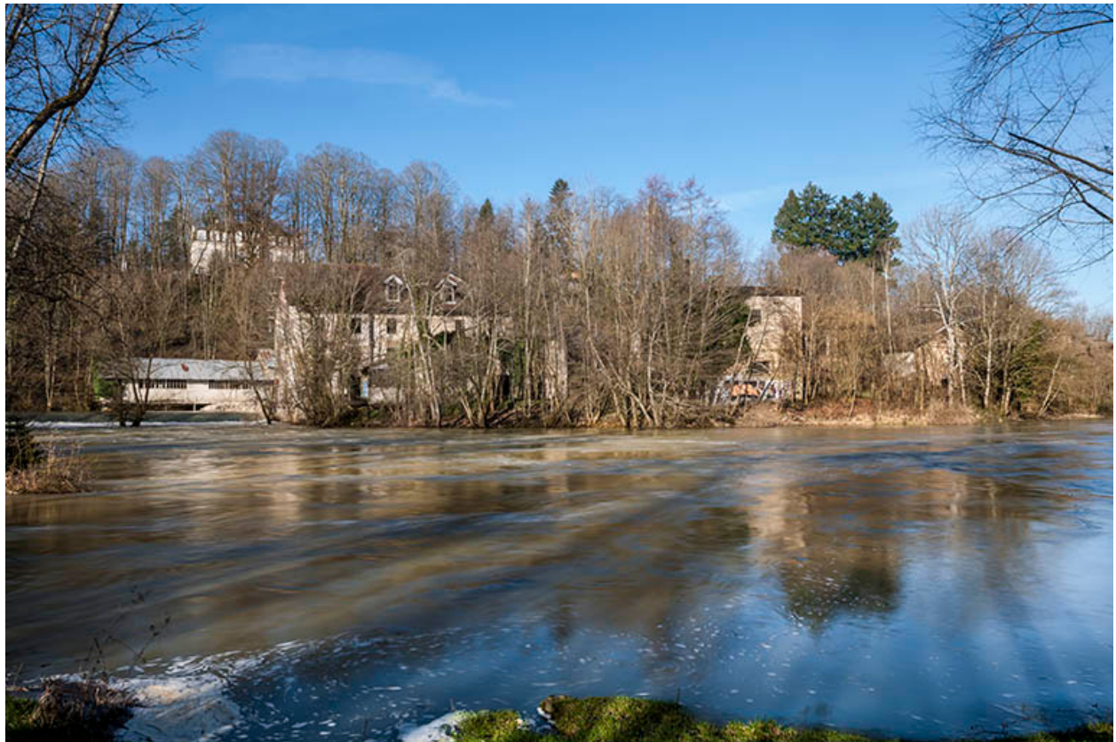
Vue d'ensemble depuis l'est (rive droite).
