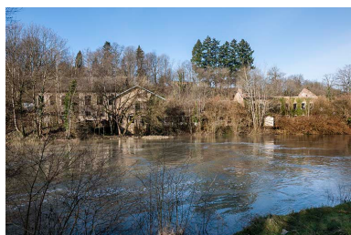
Vue d'ensemble depuis la rive droite. Phot. Jérôme Mongreville IVR43_20152500368NUC4A
