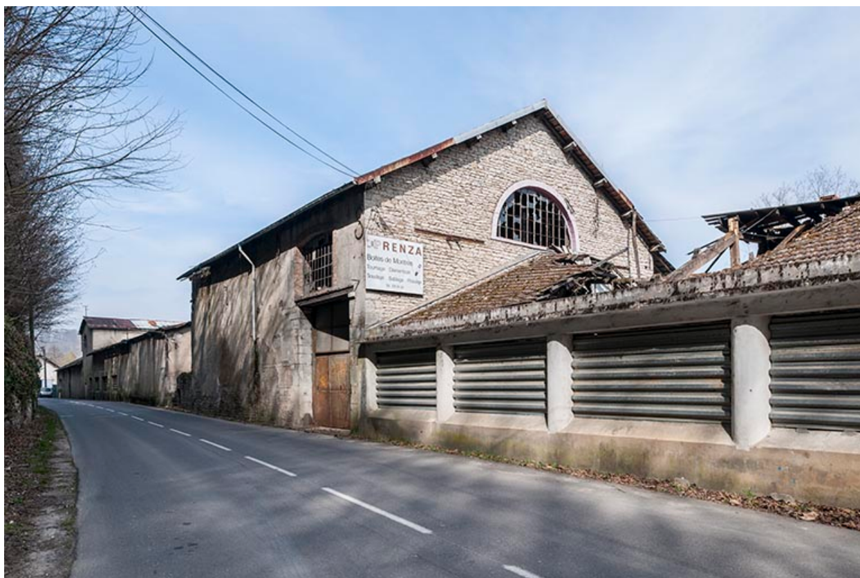
Route des Papetiers : chaufferie et magasin industriel.
