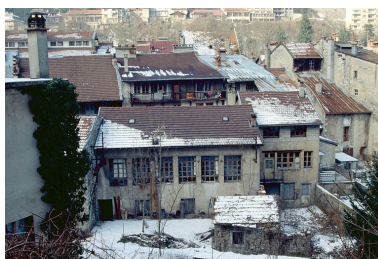
Façade postérieure des bâtiments sur cour. Phot. Laurent Poupard IVR43_19923901439ZA
