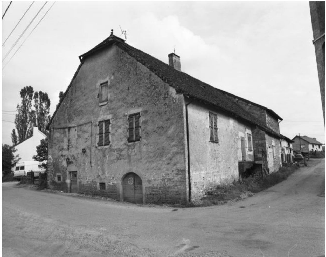
Façades postérieure et latérale droite.
