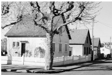
Reconstructions des années 1950 rue de Solférino, après les destructions de 1943.
