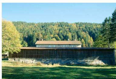
Façade postérieure du séchoir. Phot. Laurent Poupard IVR43_19903900671ZA
