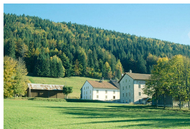
Vue d'ensemble depuis le nord. Phot. Laurent Poupard IVR43_19903900666ZA
