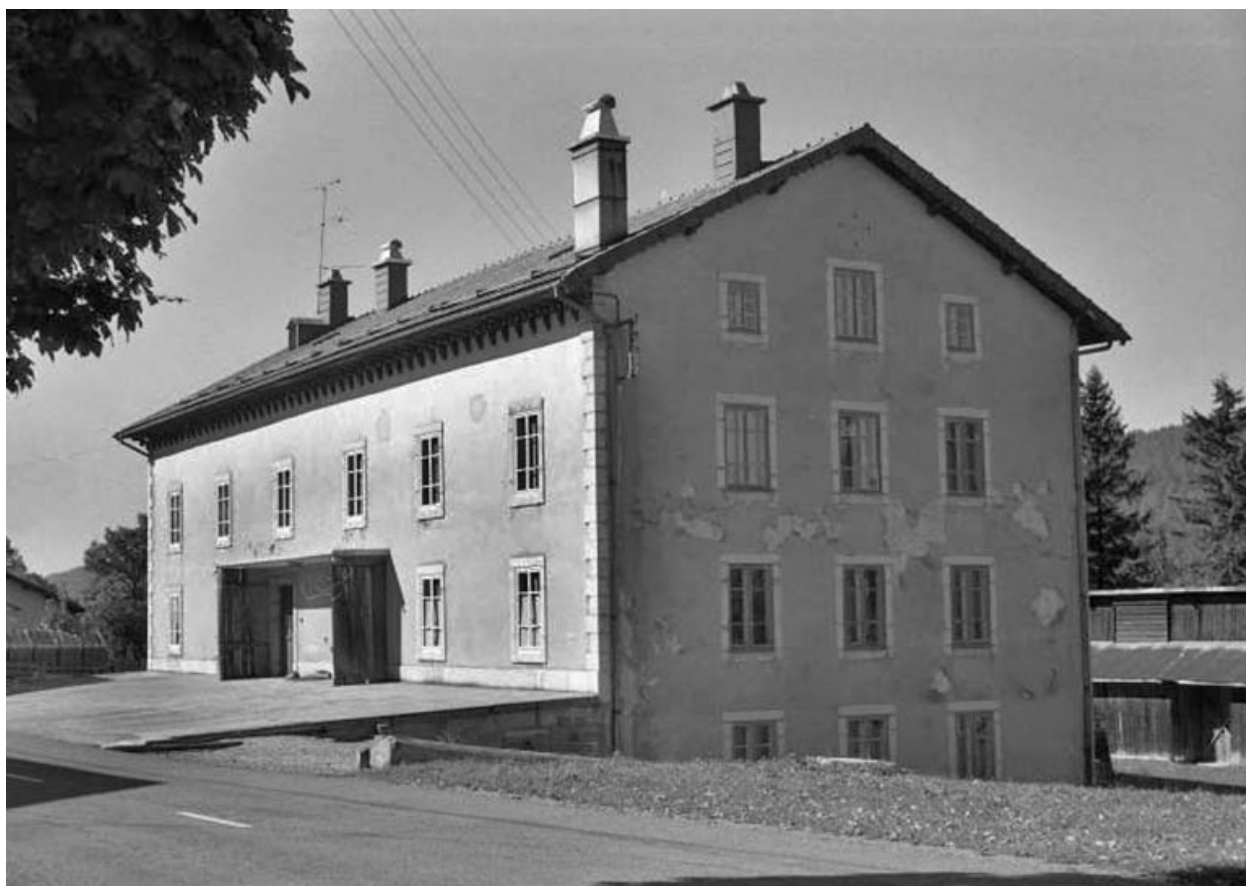
Atelier de fabrication, de trois quarts droite.
