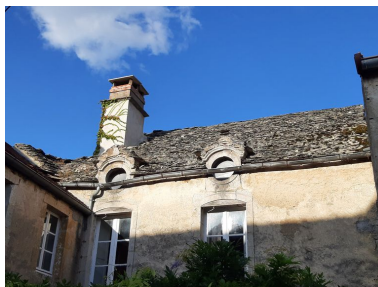
Détail du toit en laves et des oculi disposés en lucarne. Phot. Baptiste Quost IVR26_20232100283NUC2A
