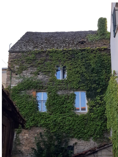
Vue du pan de toit arrière, au nord-est. Phot. Baptiste Quost IVR26_20232100285NUC2A
