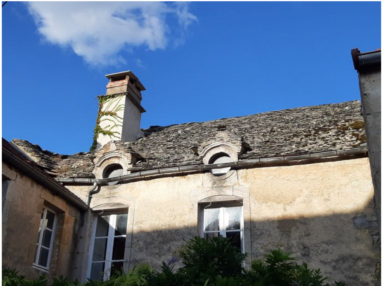
Détail du toit en laves et des oculi disposés en lucarne.
