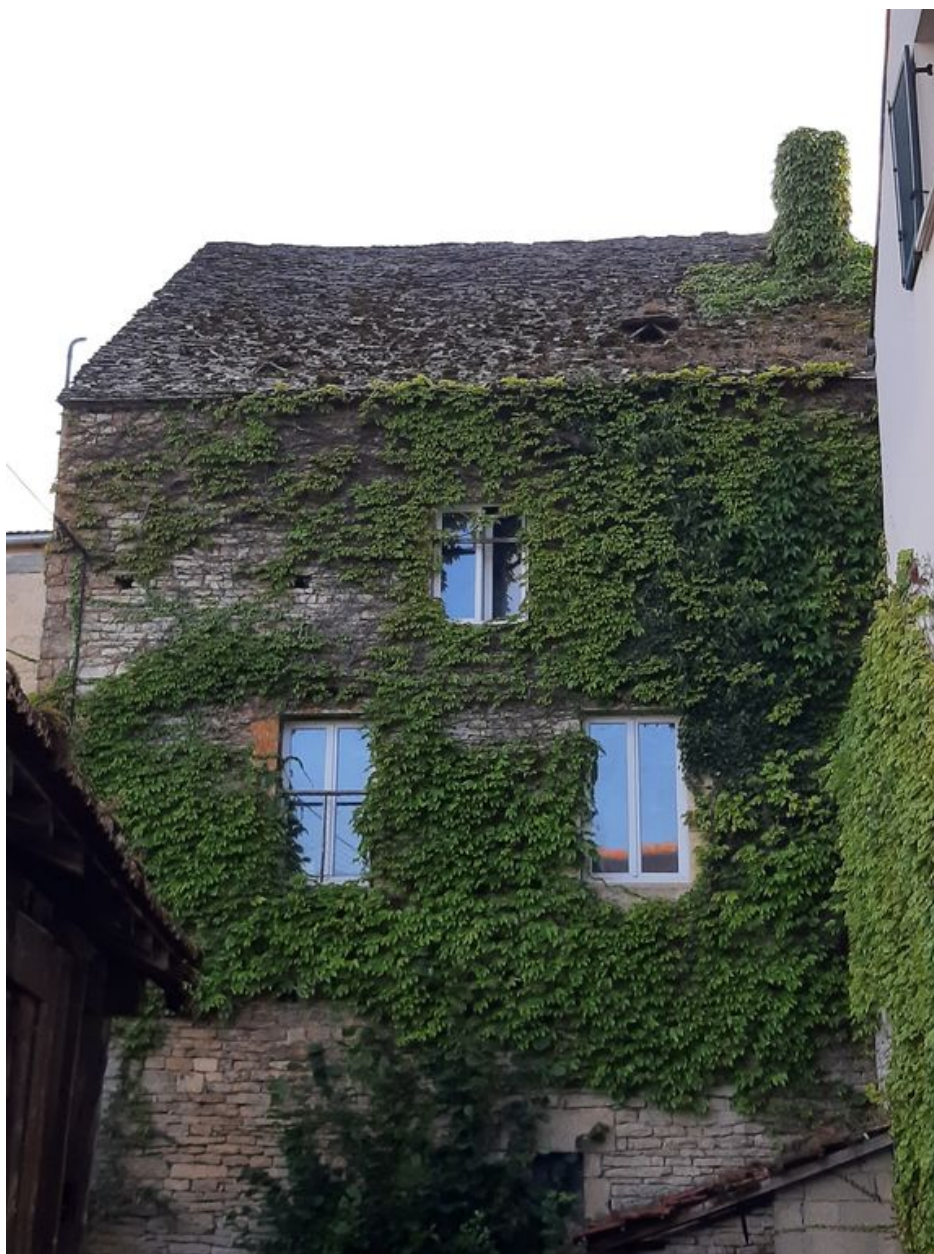
Vue du pan de toit arrière, au nord-est.
