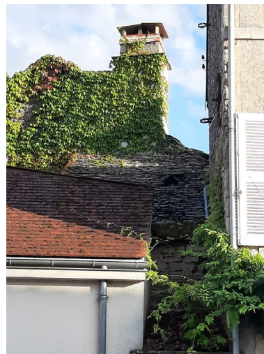
Vue de la petite extension nord-ouest couverte en lave. Phot. Baptiste Quost IVR26_20232100284NUC2A
