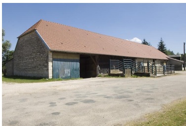
Halle à charbon (reconvertie). Phot. Jérôme Mongreville IVR43_20087000934NUC2A
