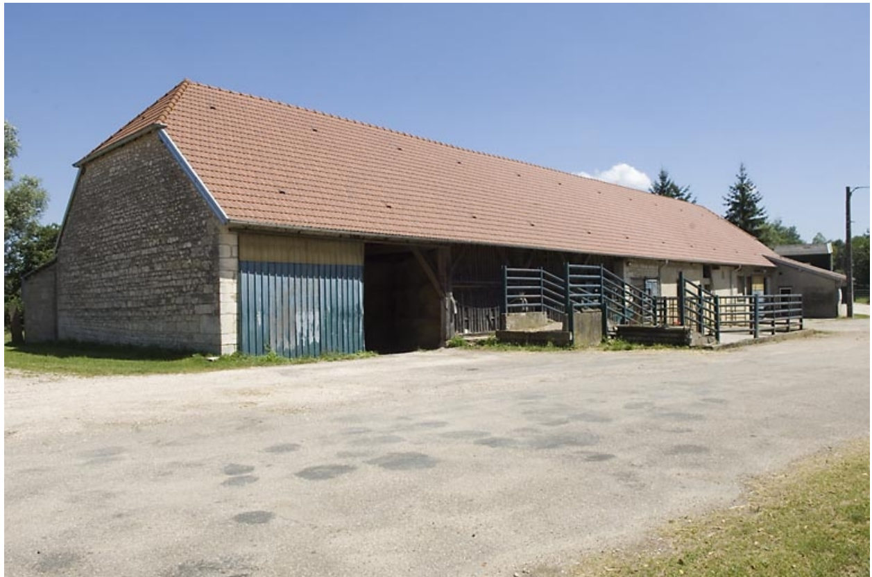
Halle à charbon (reconvertie).
