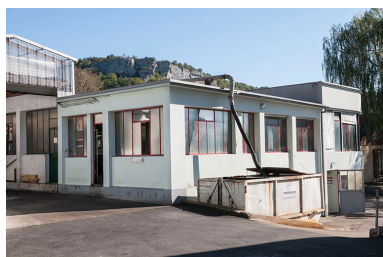
Extension est de l'atelier. Phot. Jérôme Mongreville IVR43_20152501724NUC4A
