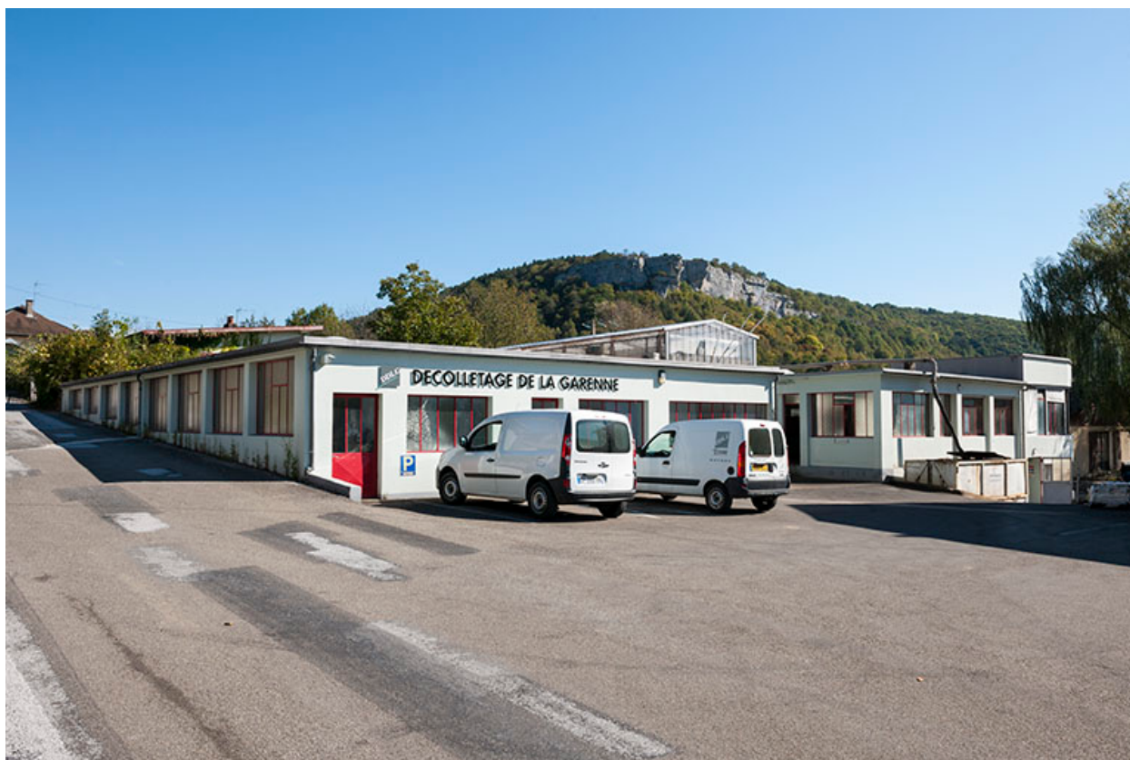
Vue d'ensemble depuis la rue.
