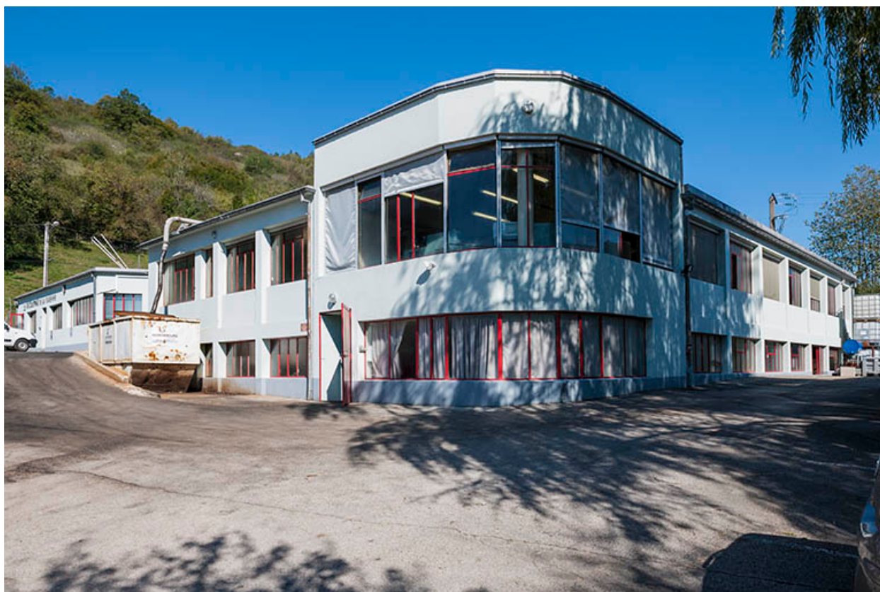
Atelier de fabrication vu depuis le sud.
