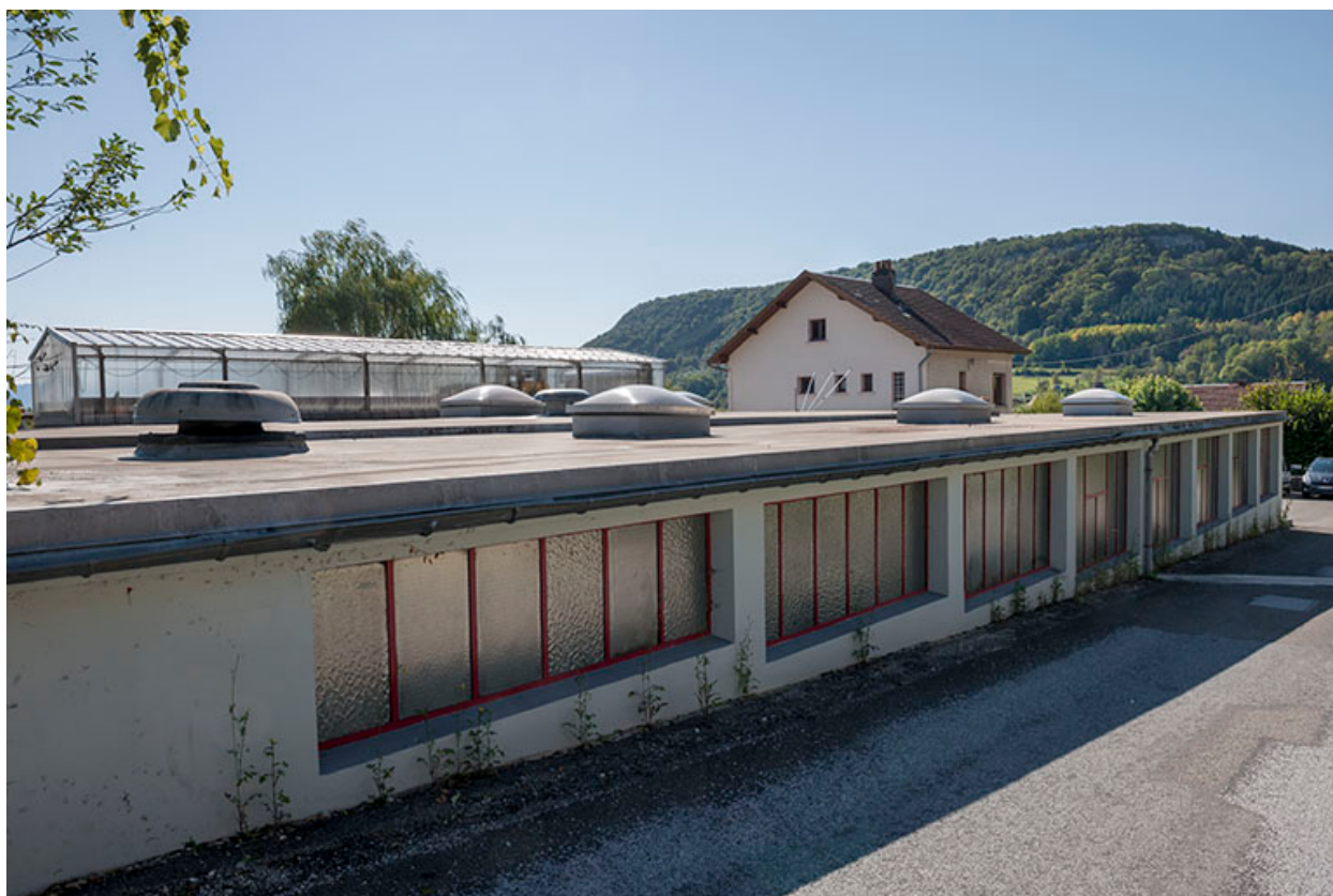
Façade sur rue de l'atelier de fabrication.
