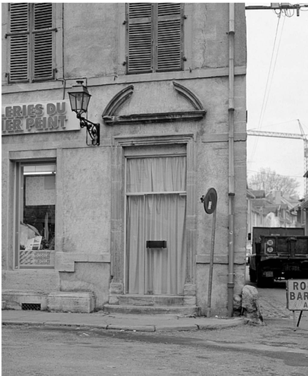
Façade antérieure, porte d'entrée.
