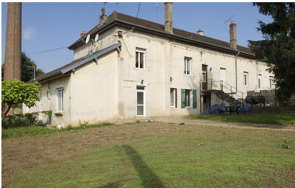
Cheminée, salle des machines et ancien atelier.
