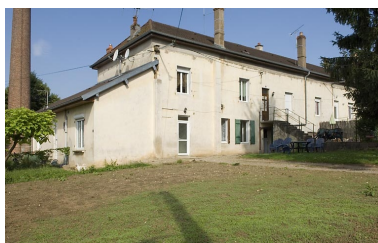
Cheminée, salle des machines et ancien atelier. Phot. Jérôme Mongreville IVR43_20087000564NUC2A
