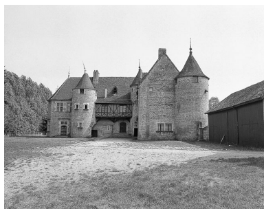
Façade ouest Phot. Yves Sancey IVR43_19753901073X
