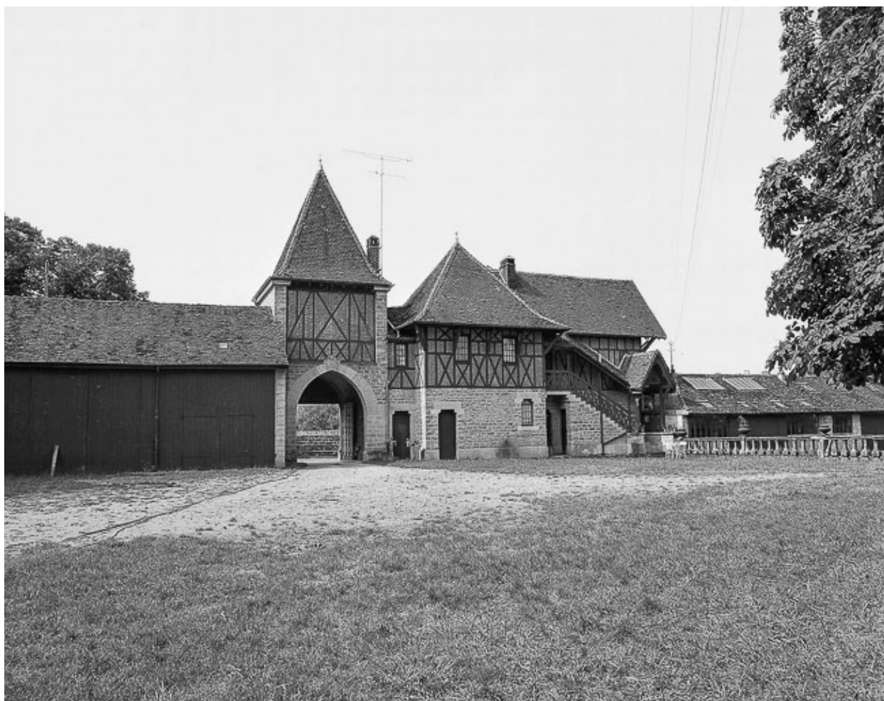
Bâtiment d'entrée : façade nord.
