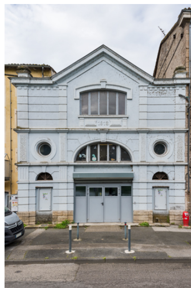
Façade postérieure, quai de Verdun. Phot. Pierre-Marie Barbe-Richaud IVR26_20257100370NUC4A
