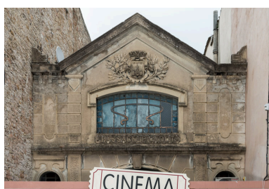
Façade antérieure : partie supérieure. Phot. Pierre-Marie Barbe-Richaud IVR26_20257100365NUC4A
