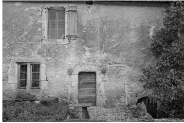
Détail de la façade antérieure. Phot. Bernard Lardière IVR43_19797000335Z
