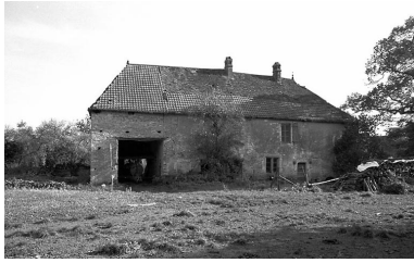
Façade antérieure. Phot. Bernard Lardière IVR43_19797000334Z
