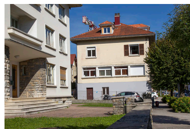
Façade latérale gauche. Phot. Yves Sancey IVR43_20132502366NUC2A
