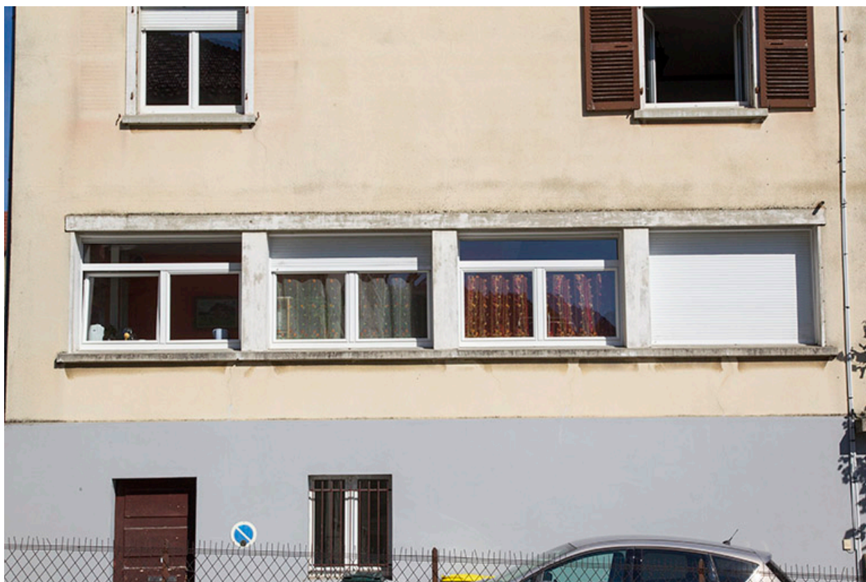
Façade latérale gauche : fenêtres d'atelier.
