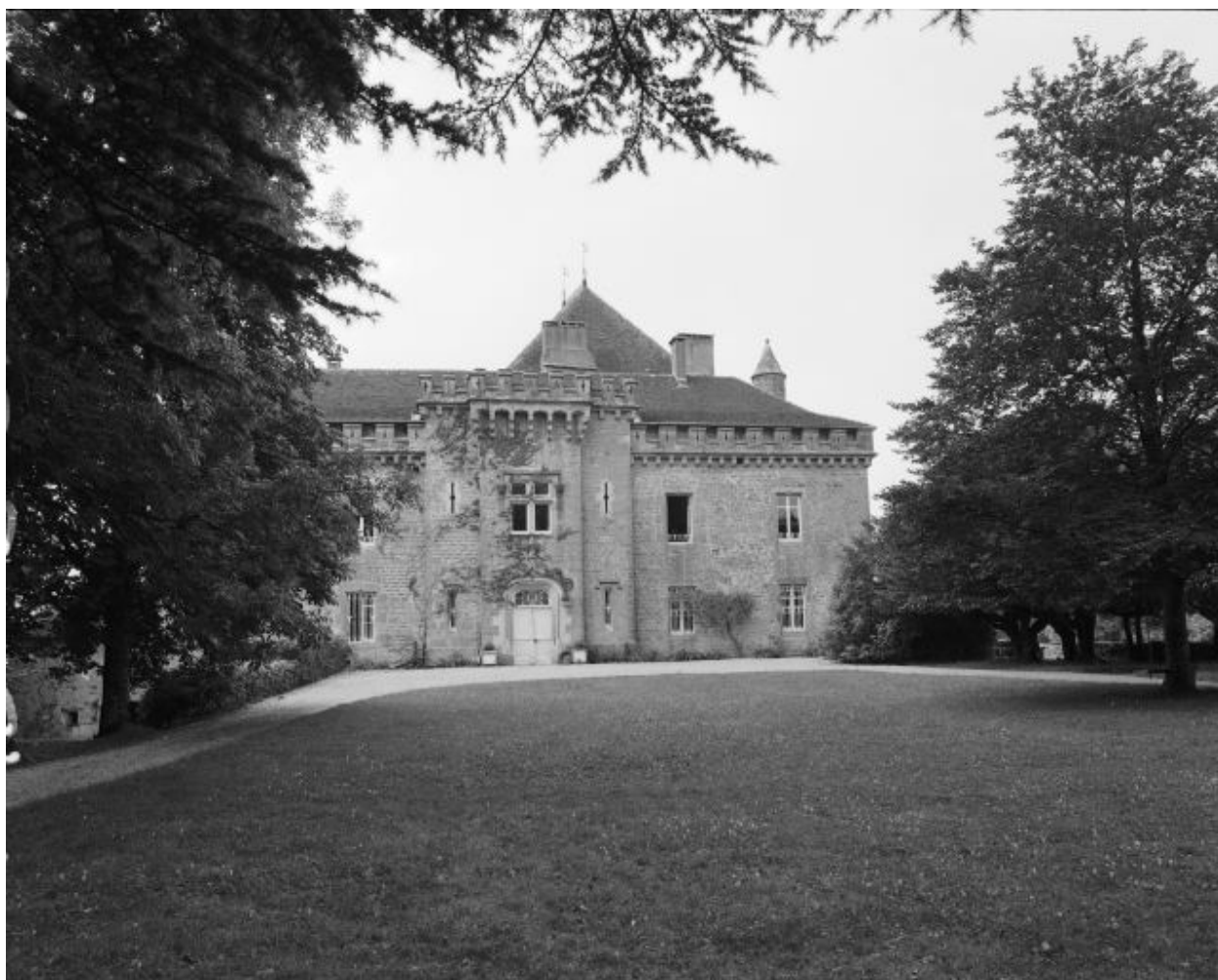
Le corps de bâtiment de façade.
