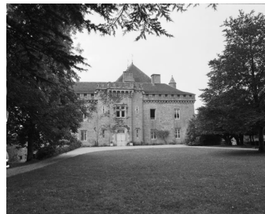
Le corps de bâtiment de façade. Phot. Yves Sancey IVR43_19753901079X
